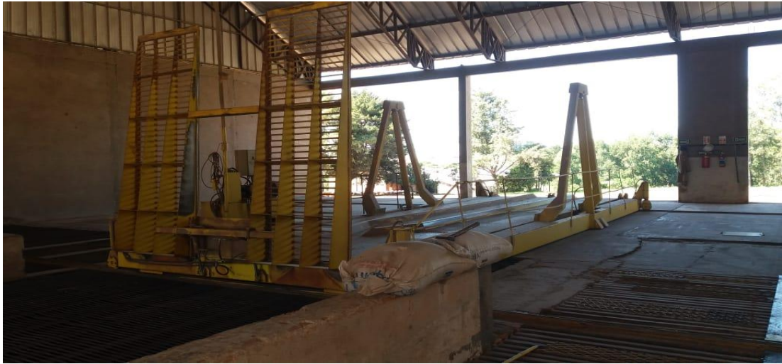
Figura 2 - Plataforma de descarga a granel (tombador)
