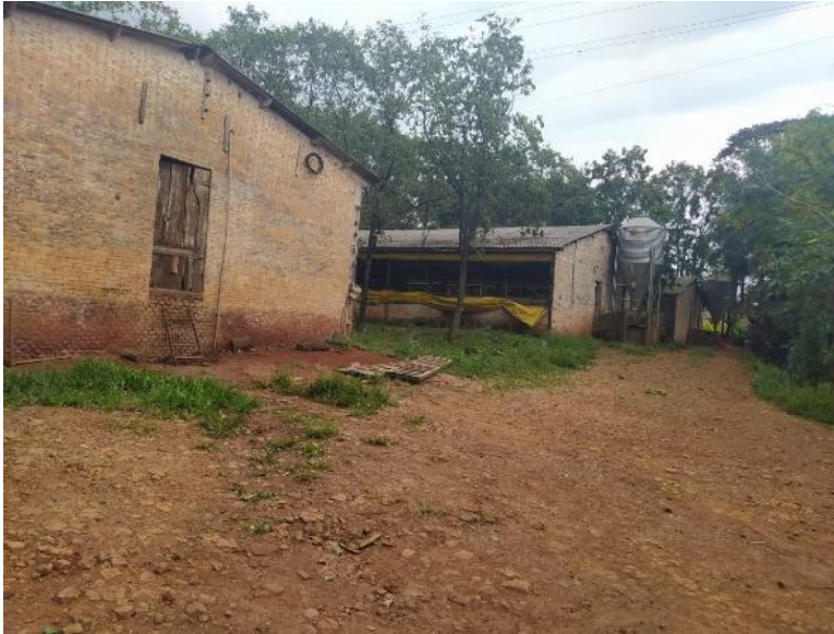
Figura 7 - Galpão da creche
