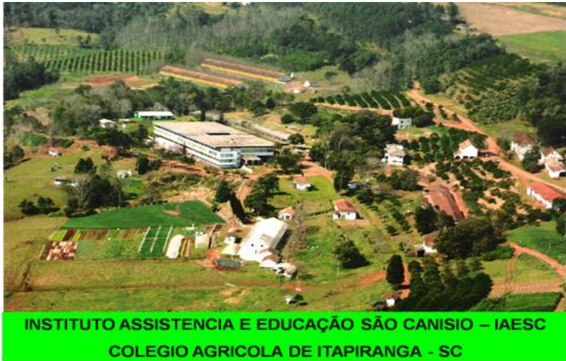
Figura 14 - Vista aérea das estruturas do colégio agrícola
