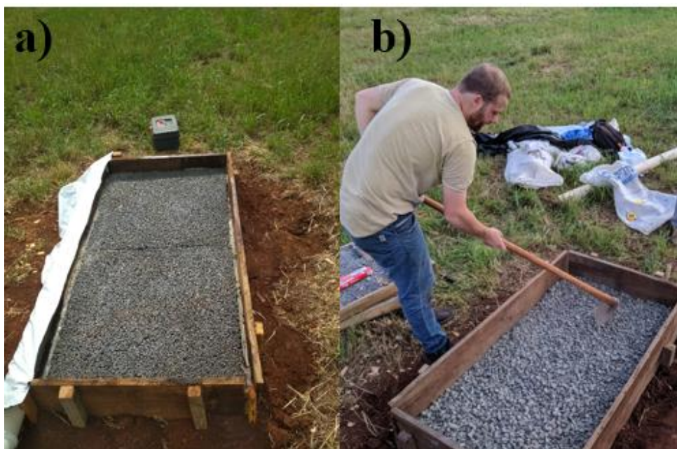
Figura 8 – a) Modelo de pavimento de concreto permeável instalado; b) Execução da camada de base.
