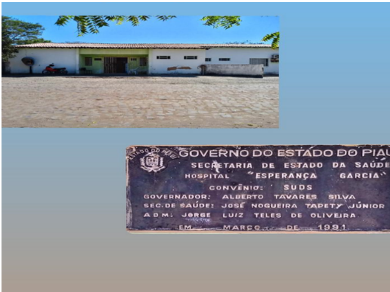
Ilustração 13 – Fachada do hospital e placa de inauguração
