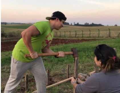
Figura 3 – Montagem do sistema de captação e armazenamento da água da chuva. (a) Colocação dos pontaltes de madeira para sustentação da base do telhado; (b) Construção da conexão entre a calha e a bombona e (c) Colocação e ajuste das telhas de cerâmica.
