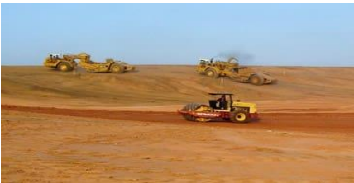
Figura 9 – Compactação de solo em área de aterro.
