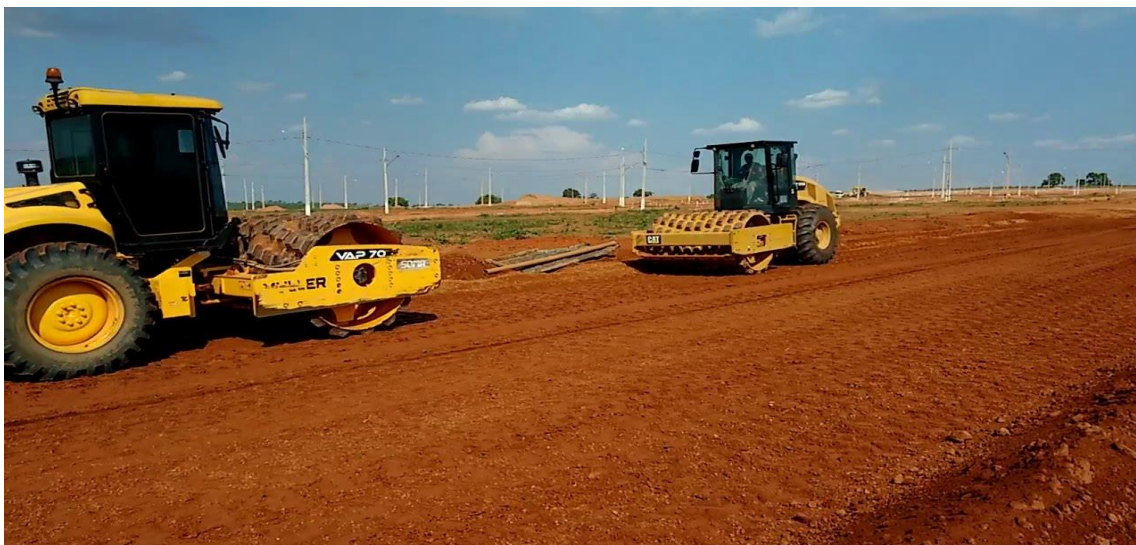
Figura 8 – Compactação de solo em vias públicas.
