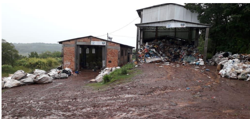
Figura 6 – Vista frontal da Central
