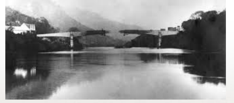
Ponte Emilio Baumgart em construção (Fonte: acervo da prefeitura de Herval).
