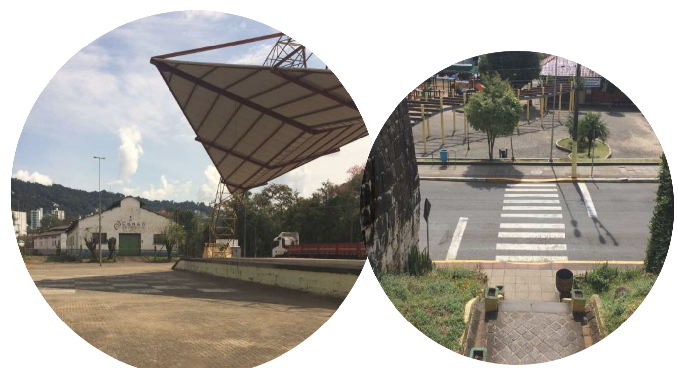
3 Fachada norte do armazém de frente para a praça. 4 Visual da praça através de acesso peatonal
