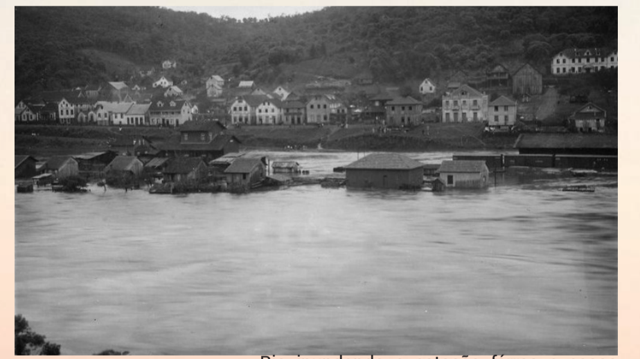
Rio inundando a estação férrea e casas (Fonte: acervo da prefeitura de Herval).
