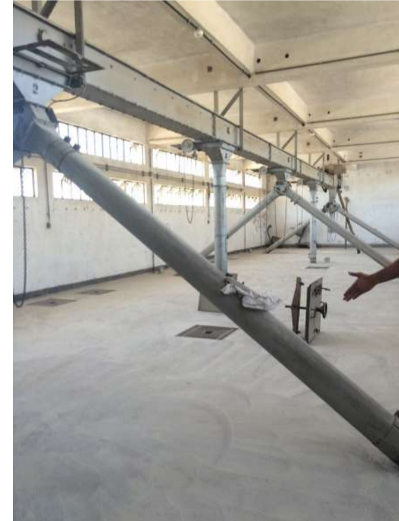
Sexto pavimento, onde ocorre a distribuição do milho entre as 6 células ou as 2 entre-células (Fonte: autora).
