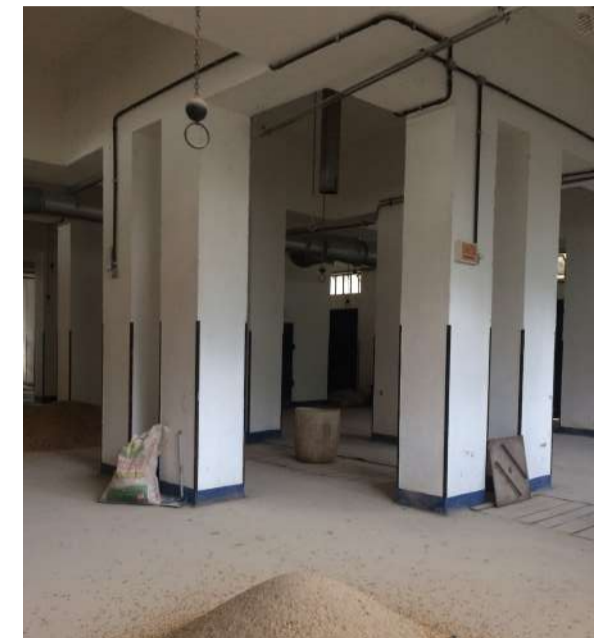
Imagem do pavimento térreo, colunas que sustentam os silos (Fonte: autora).
