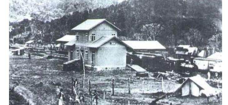
Estação destruída em 1951 (Fonte: acervo da prefeitura de Herval).
