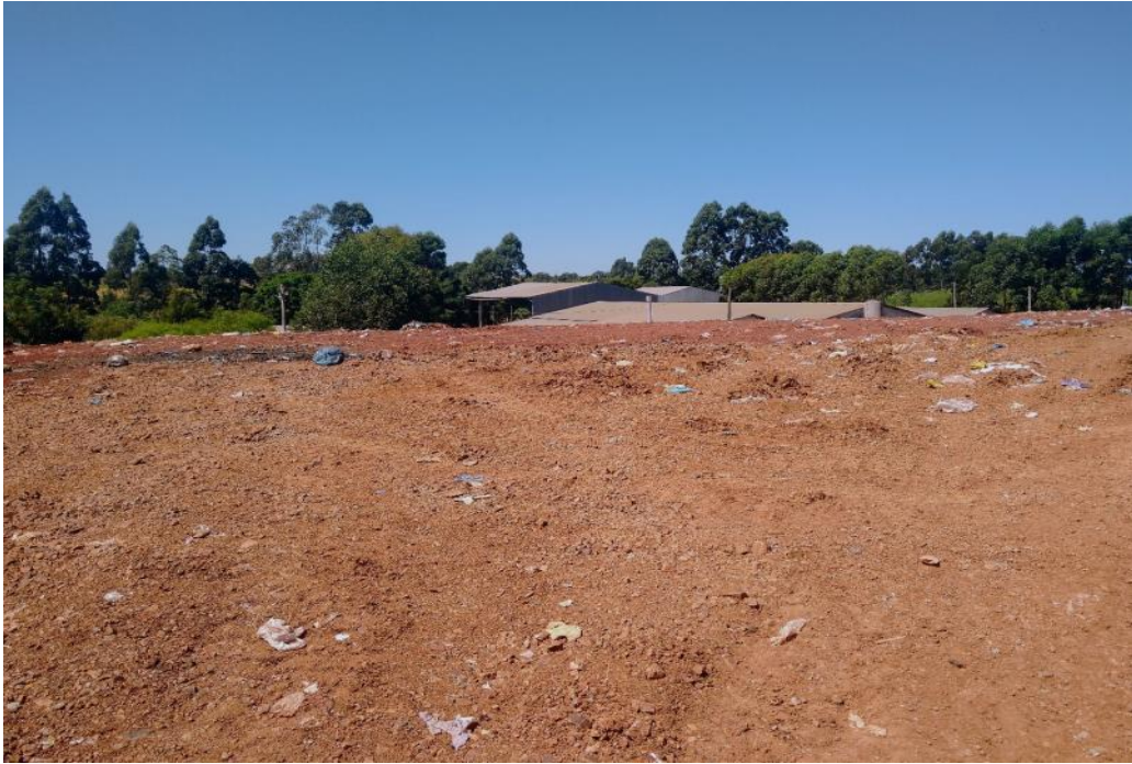
Figura 19 – Aterro sanitário com recobrimento e compactação ao término da jornada de trabalho
