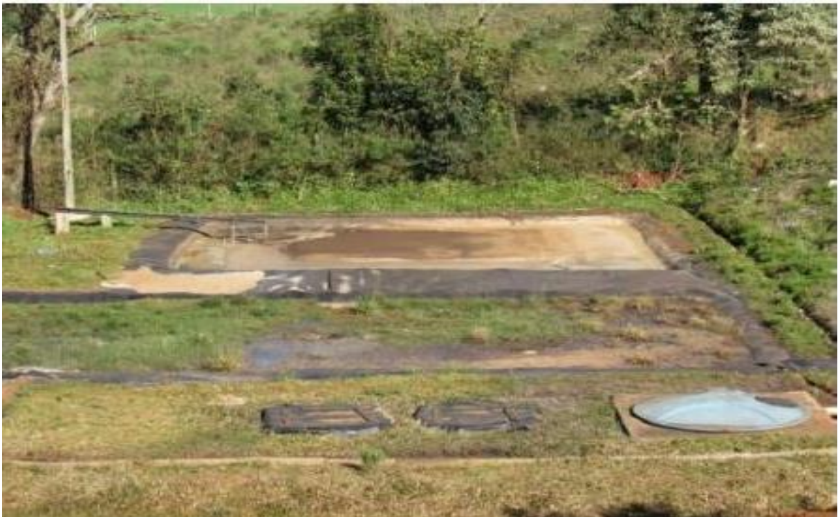
Figura 21 – Sistema de tratamento do aterro sanitário
