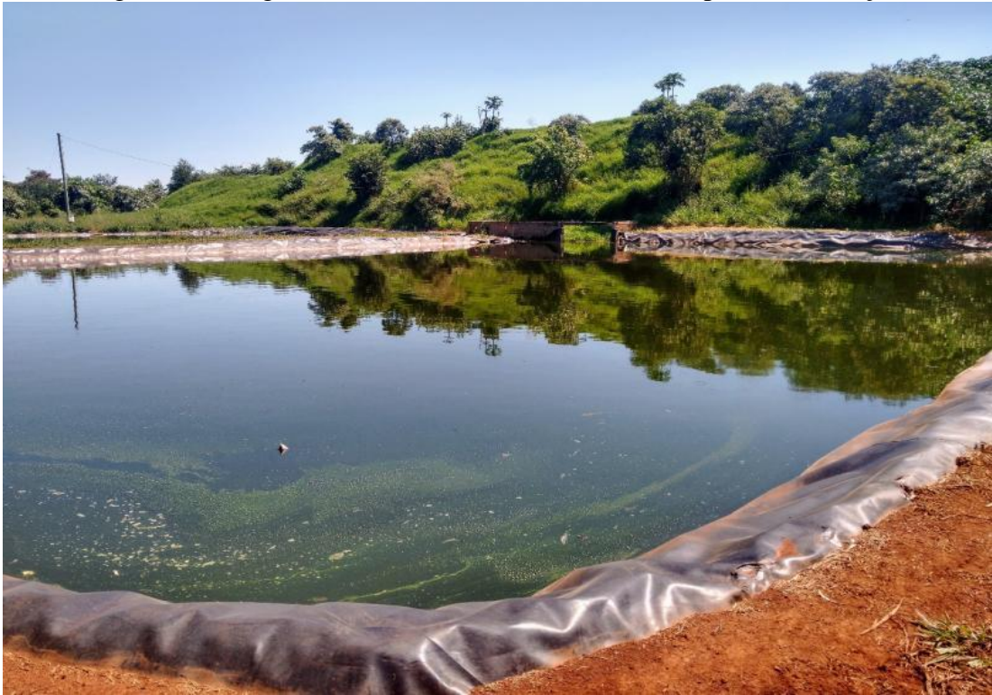
Figura 22 – Lagoas do aterro controlado e utilizadas para recirculação
