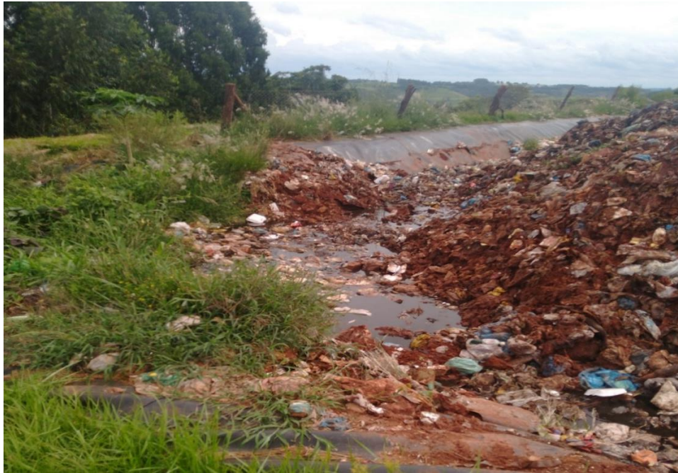
Figura 20- Acumulo de água pluvial com chorume
