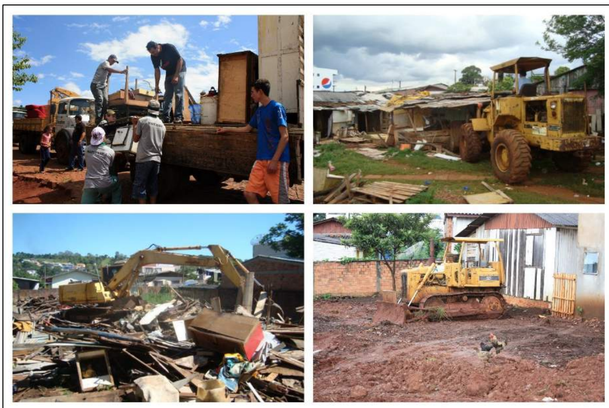
Figura 16 – Fotografia: remoção e destruição do Cabo Dito
