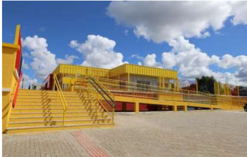
Figura 16: Estrutura da escola.
