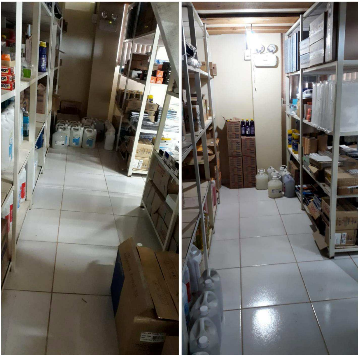
Figura 13 - Antes e depois iluminação
