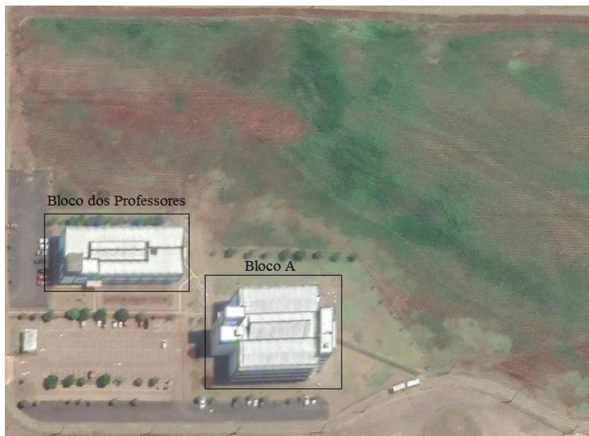
Figura 4: Bloco A e Bloco dos Professores
