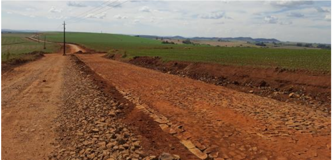
Fotografia 9 - Estrada rural do assentamento
