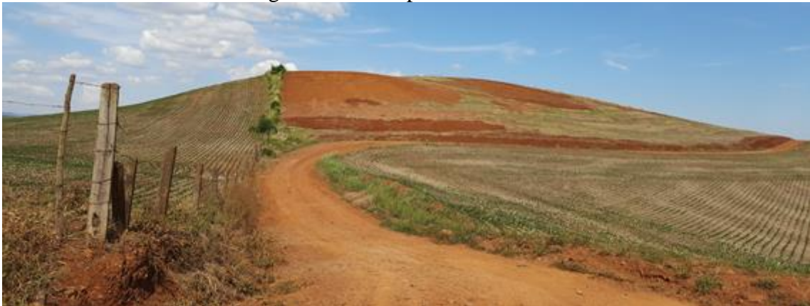
Fotografia 10 - Limpeza de áreas do lote
