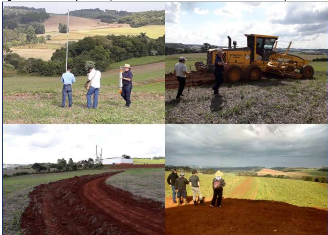
Fotografias 1 a 4 - Representação do levantamento altimétrico e reconstrução do terraço.
