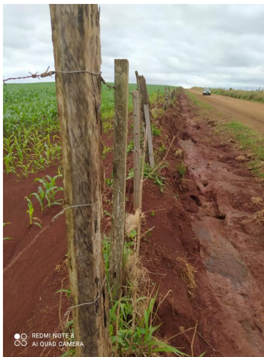
Figura 1: Ilustração de um problema de erosão em laterais de estradas que circundam lavouras, encontrado na região missioneira do RS.
