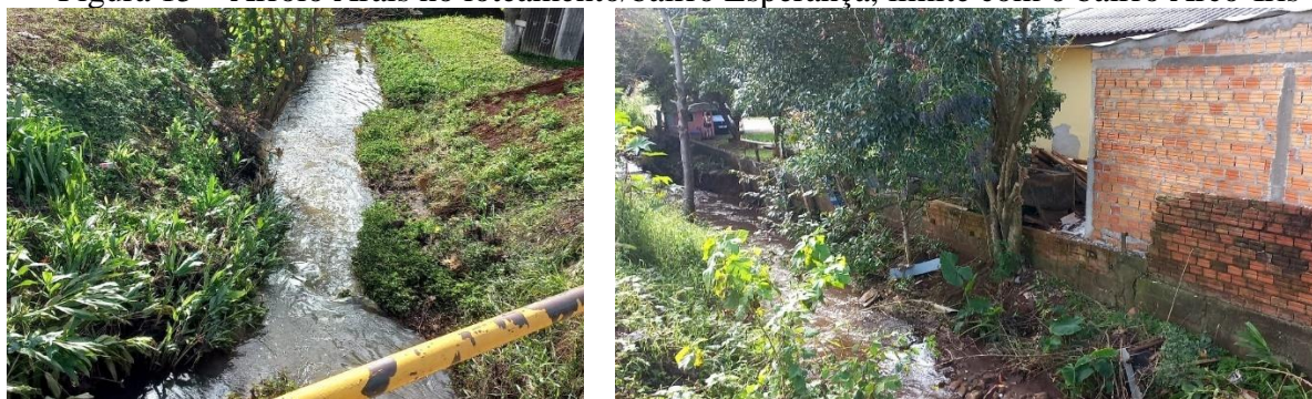
Figura 15 – Arroio Araís no loteamento/bairro Esperança, limite com o bairro Arco-Íris
