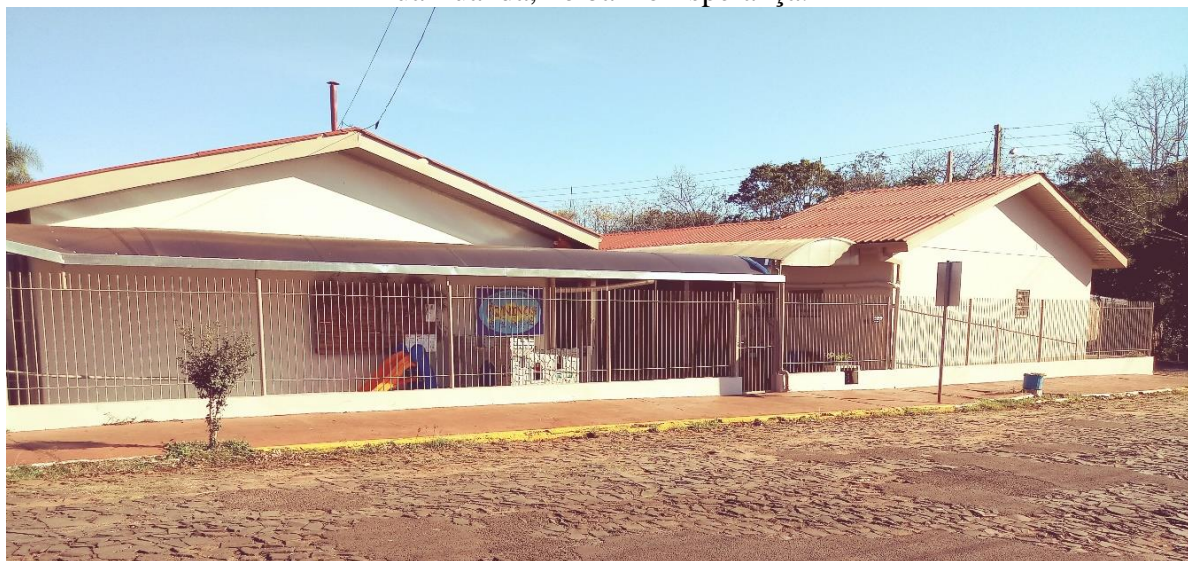
Figura 20 – Fachada atual da Escola Municipal de Educação Infantil P'Q'Ninos, situada na rua Luanda, no bairro Esperança.
