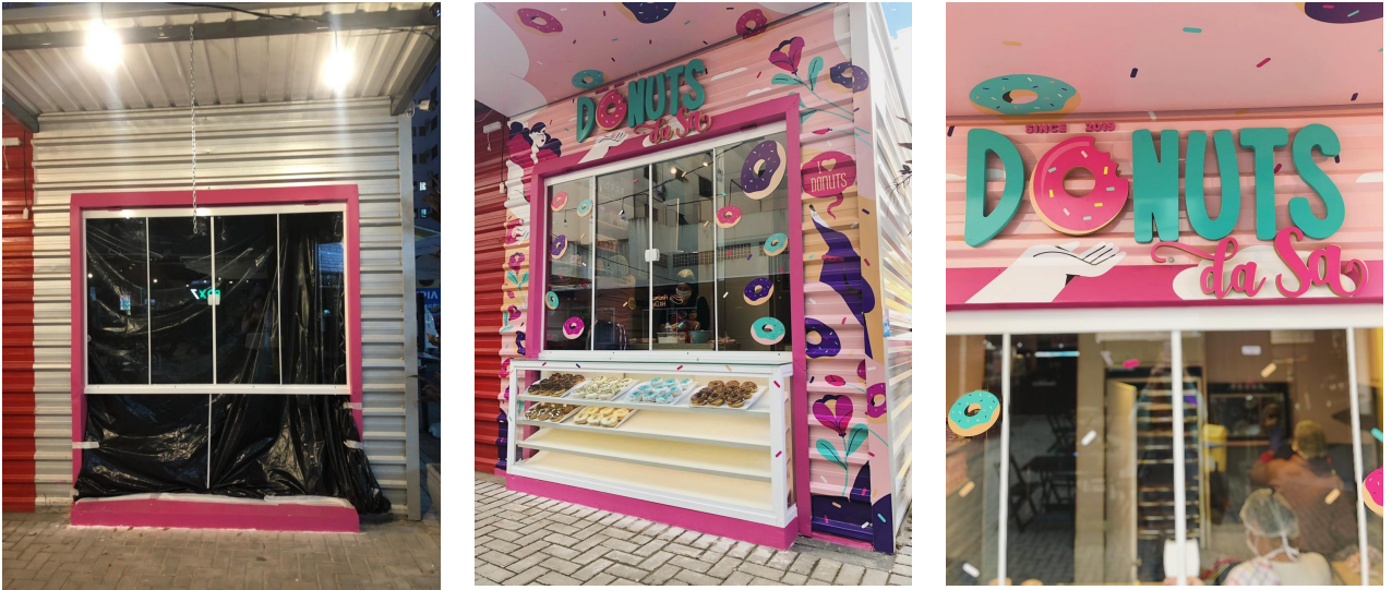
Fotografia 5 - Etapas de finalização do espaço físico da Donuts da Sa.
