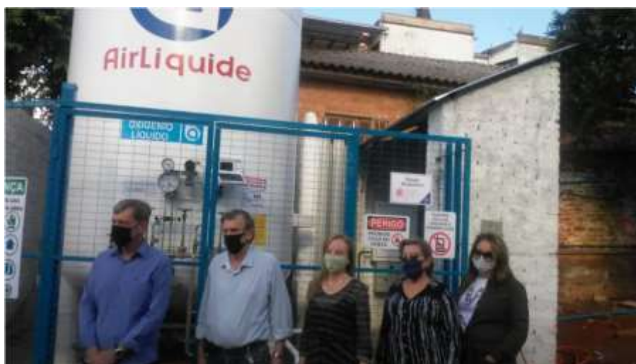
Figura 3 - Foto tirada com o reservatório de oxigênio líquido
