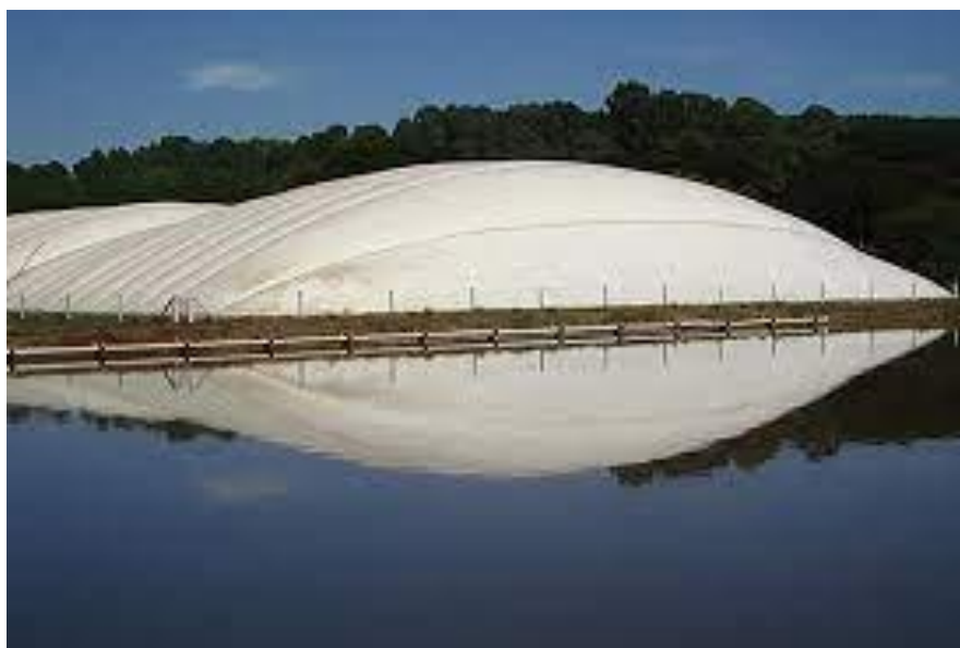
Figura 11. Biodigestor de dejetos suínos. Fonte: Revista Rural, 2020.
