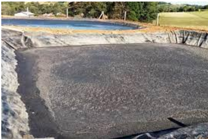
Figura 7. Bioesterqueira de armazenamento de dejetos. Fonte: Emater, 2022.
