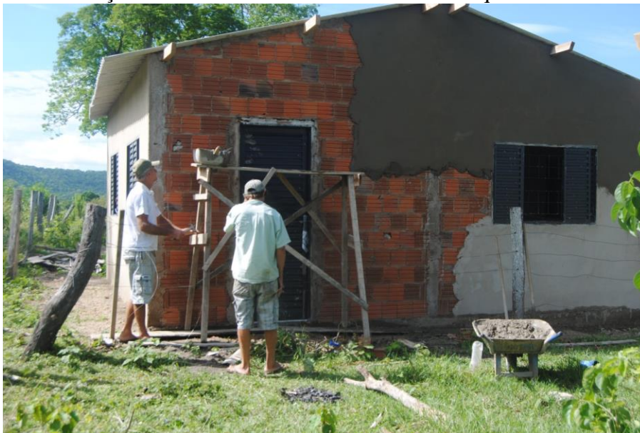
Figura 37– Construção da Casa do Mel no Assentamento Taquaral
