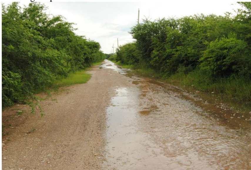
Figura 27 – Águas pluviais escorrendo em estrada vicinal no Assentamento Taquaral
