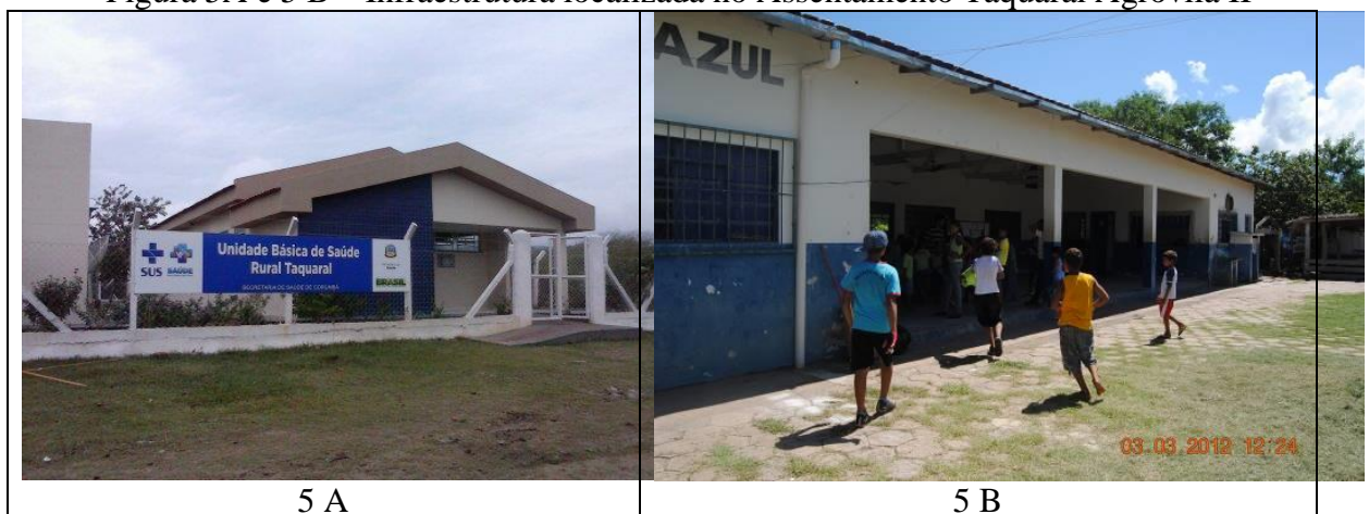
Figura 5A e 5 B – Infraestrutura localizada no Assentamento Taquaral Agrovila II
