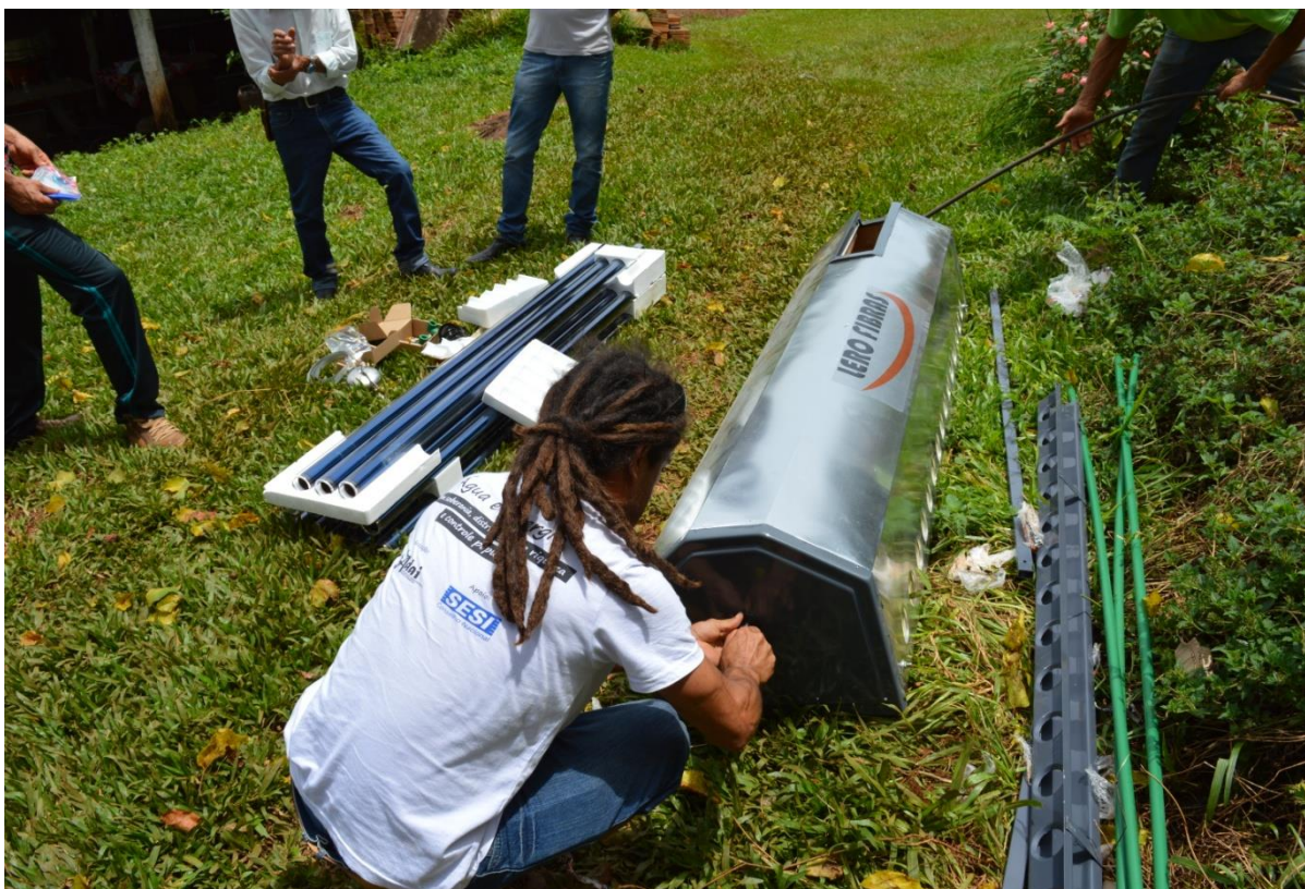
Foto 8 - Distribuição dos kits ASBC (placa solar, boiler, e encanamentos)
