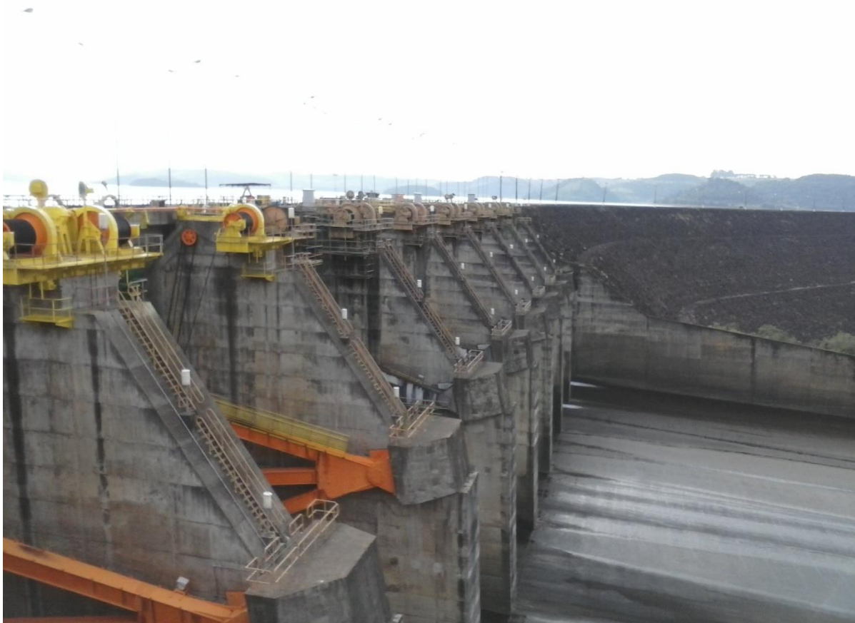
Foto 4 - Comportas da Barragem de Salto Santiago no rio Iguaçu
