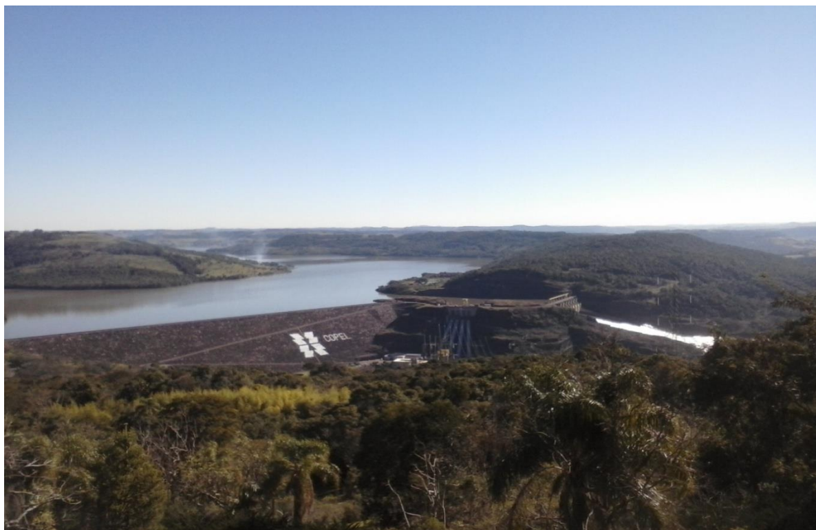
Foto 2 - Cobertura vegetal próximo à Usina de Salto Segredo
