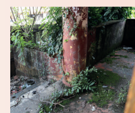
FOTO PILAR ACESSO PRINCIPAL Foto: o Autor 2022
