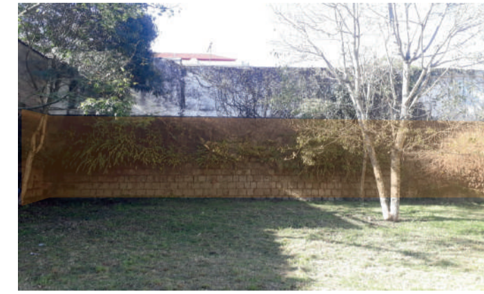
MURO DE CONTENÇÃO DE PEDRA BASALTO Foto: o Autor
