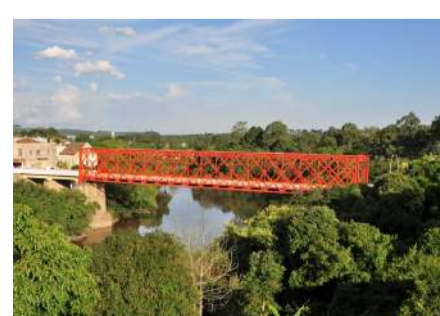
Figura 01: Ponte Metálica Dr. Diniz Assis Henning, 2020
