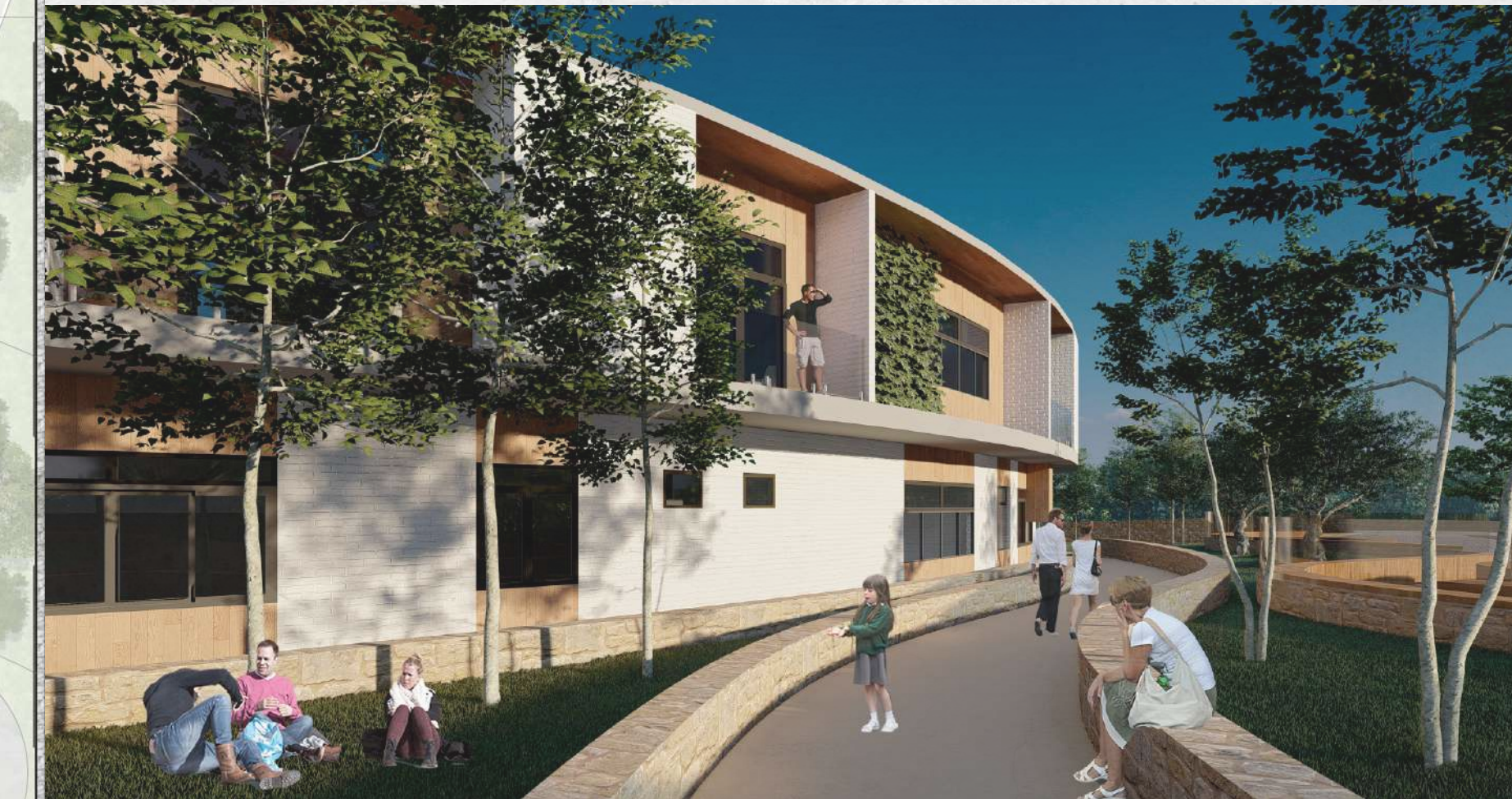
Rampa de acesso pedestres
