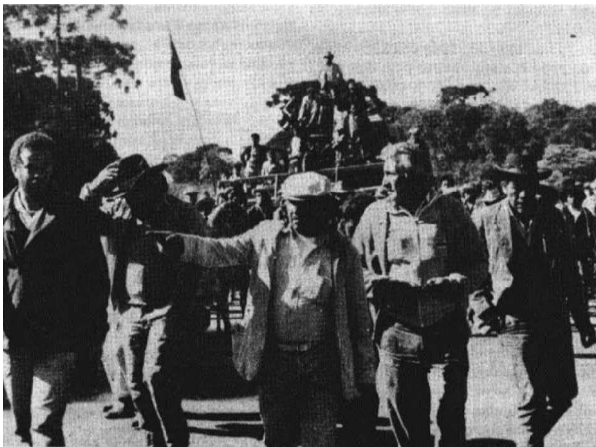
Figura 17 – Obstrução da Rodovia PR-281
