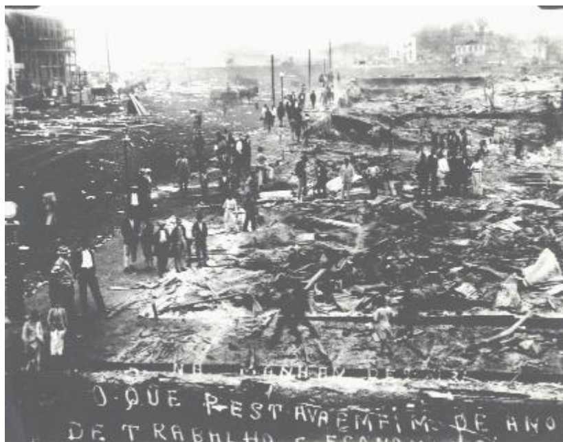
Figura 20 - Incêndios do ano de 1931
