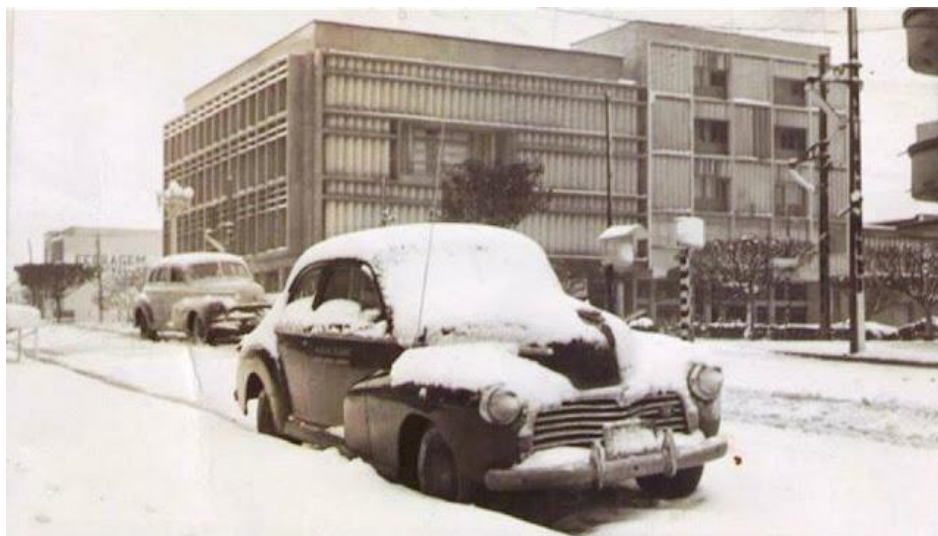
Figura 21 - Nevasca em Erechim em 1942
