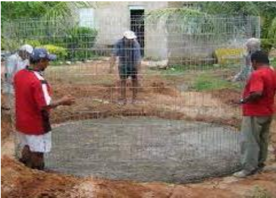
Figura 9 - Construção de uma cisterna de tela de alambrado
