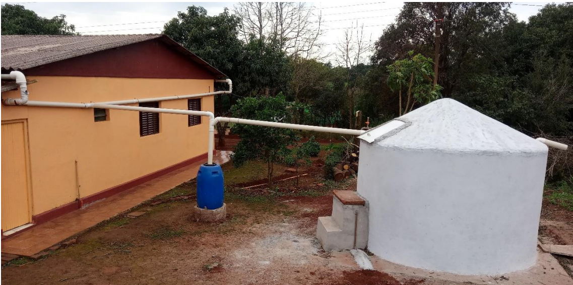
Figura 66 - Imagem lateral do sistema de captação finalizado
