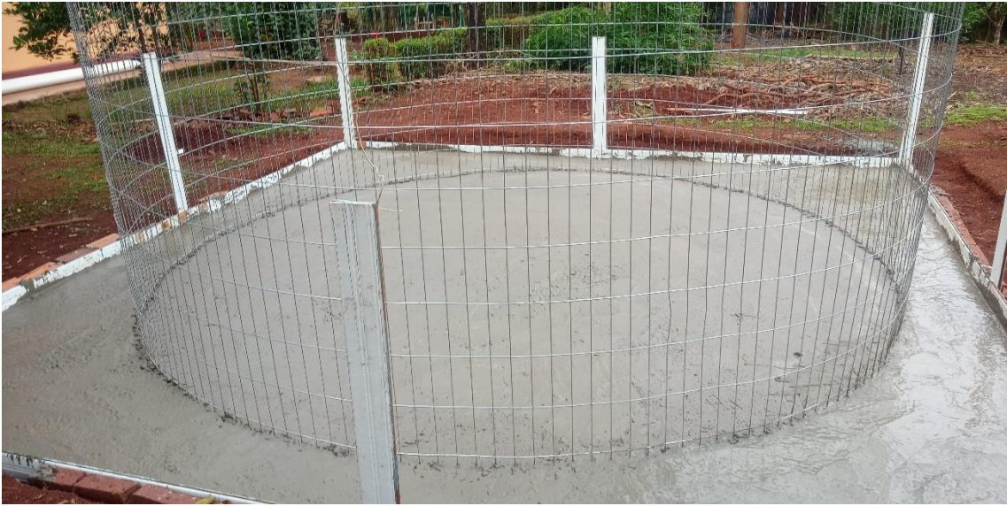
Figura 41 - Base da cisterna recém finalizada
