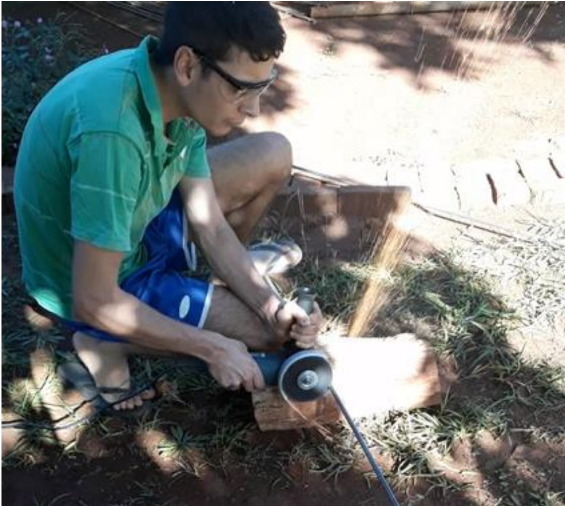
Figura 35 - Cortando as barras de ferro para a base da cisterna
