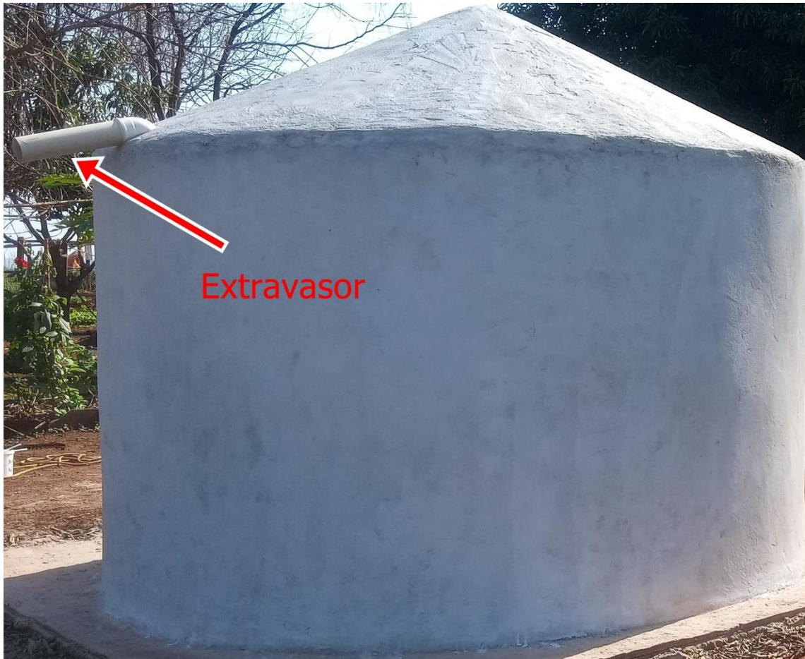
Figura 61 - Extravasor instalado com a tela de mosquiteiro
