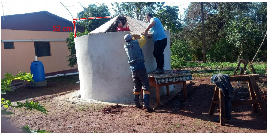
Figura 53 - Colocação das placas da cisterna
