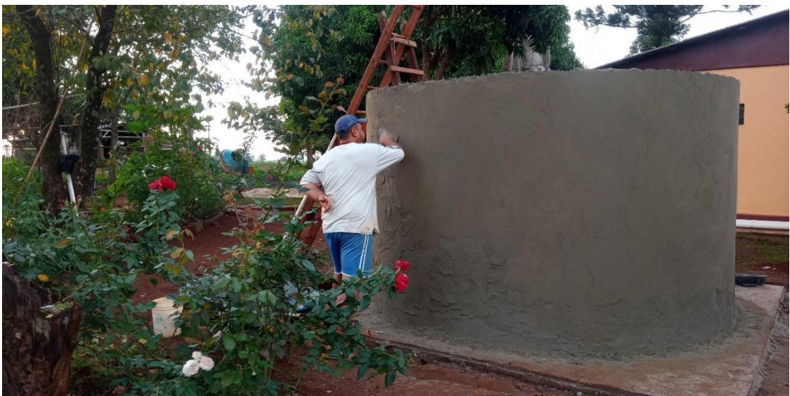
Figura 46 - Finalização da terceira camada externa
