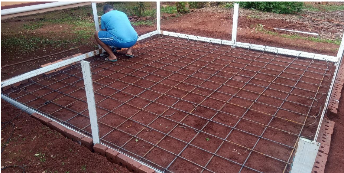
Figura 37 - Colocação da estrutura de ferro no local onde foi construída a cisterna
