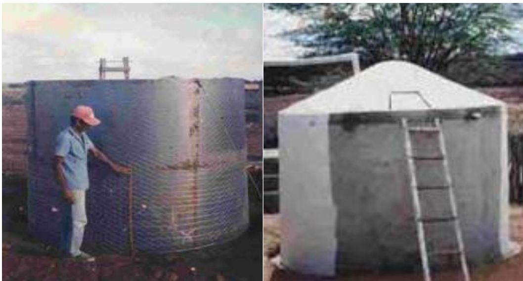
Figura 8 - Cisterna de concreto com tela de arame
