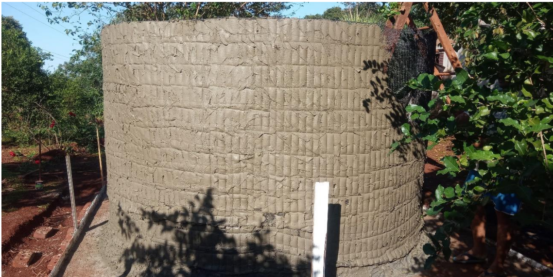
Figura 44 - Primeira camada externa já finalizada
