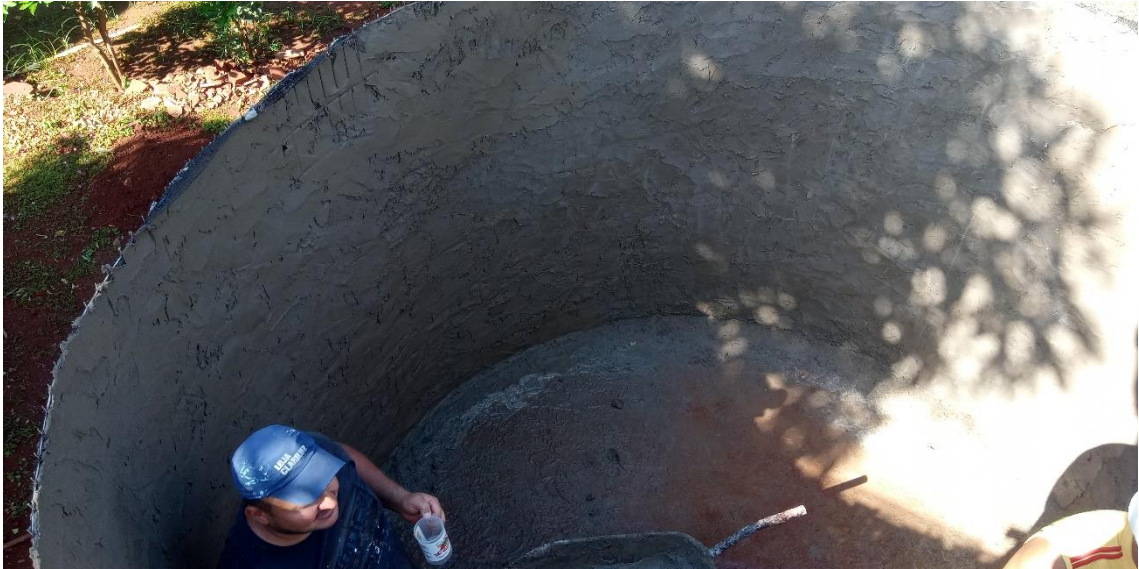
Figura 45 - Construção da primeira camada interna
