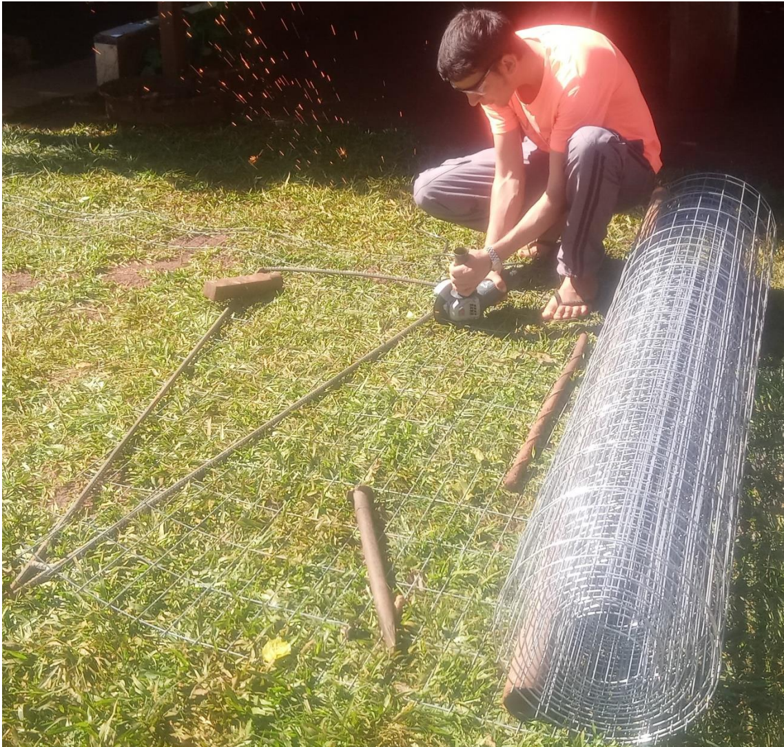
Figura 31 - Cortando a tela de alambrado para as placas
