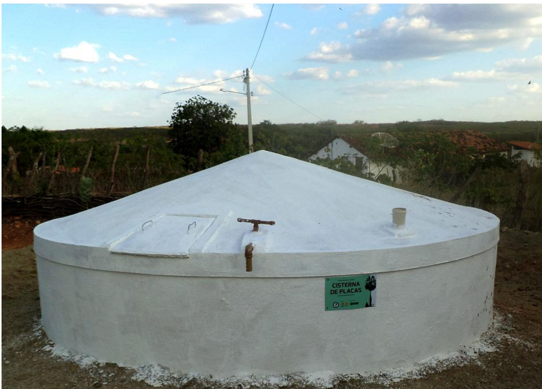
Figura 7 - Cisterna de placas depois de pronta
