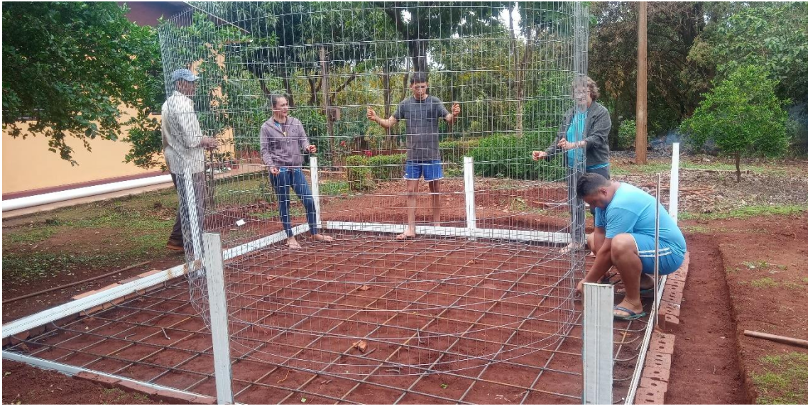
Figura 38 - Posicionamento da tela de alambrado para a construção
