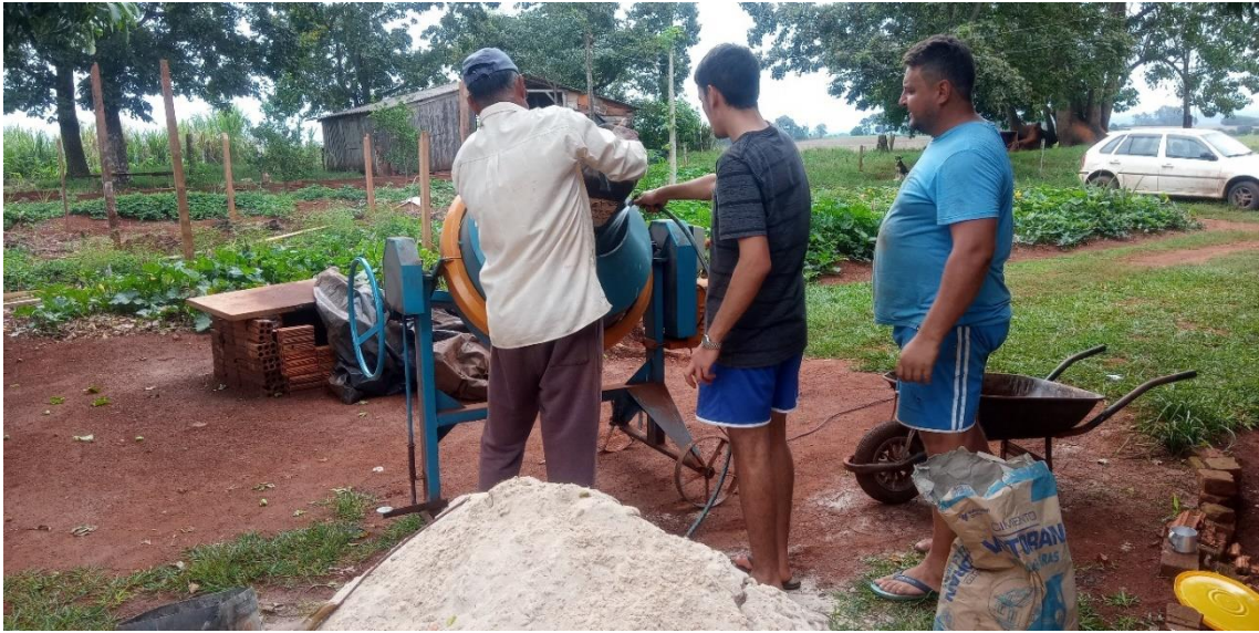
Figura 32 - Preparo do concreto
