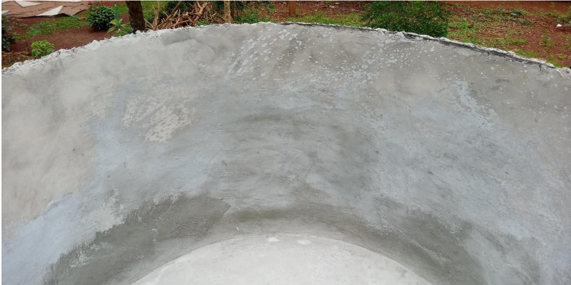
Figura 47 - Parte interna da cisterna finalizada
