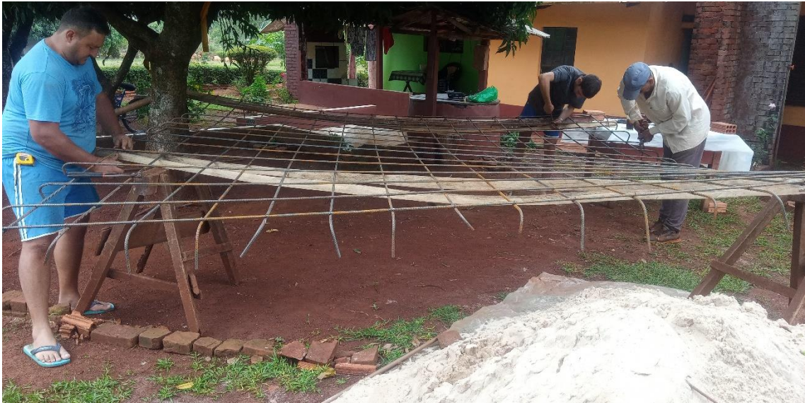
Figura 36 - Construção da estrutura de ferro para a base da cisterna
