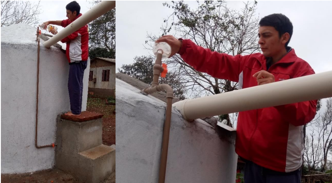
Figura 74 - Remoção do ar da tubulação para o teste de irrigação
