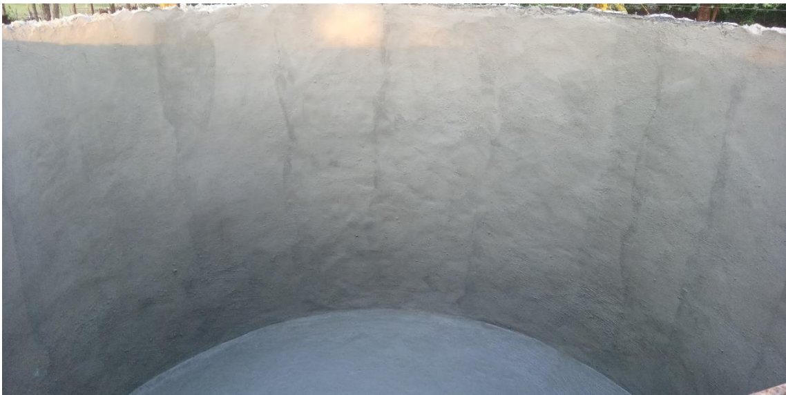
Figura 51 - Aplicação finalizada do impermeabilizante
