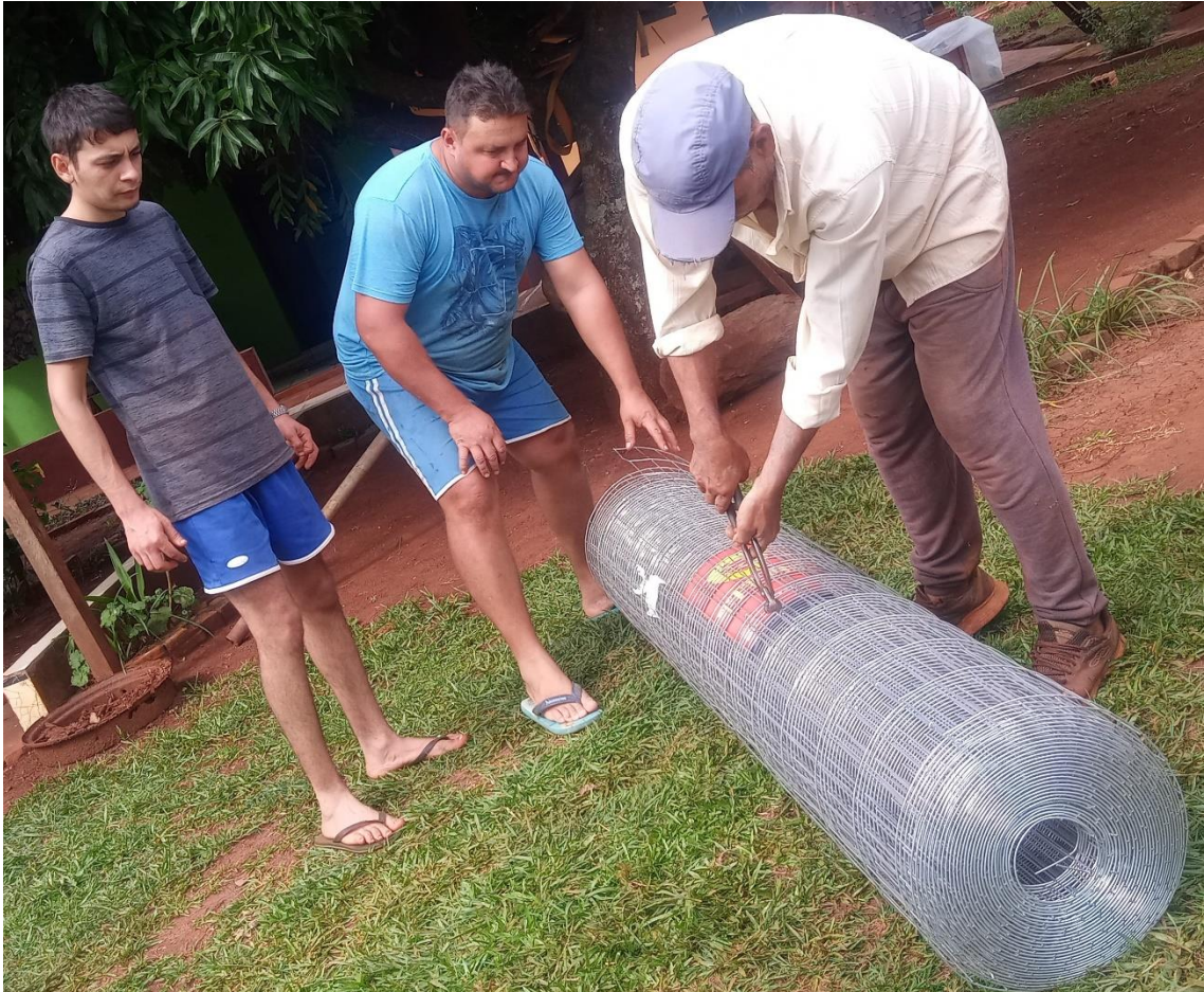
Figura 30 - Tela utilizada para a construção da cisterna
