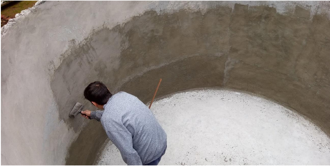
Figura 50 - Aplicação do impermeabilizante
