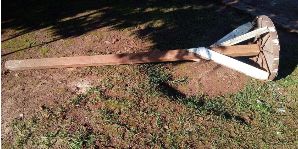
Figura 52 - Escora para apoiar as placas
