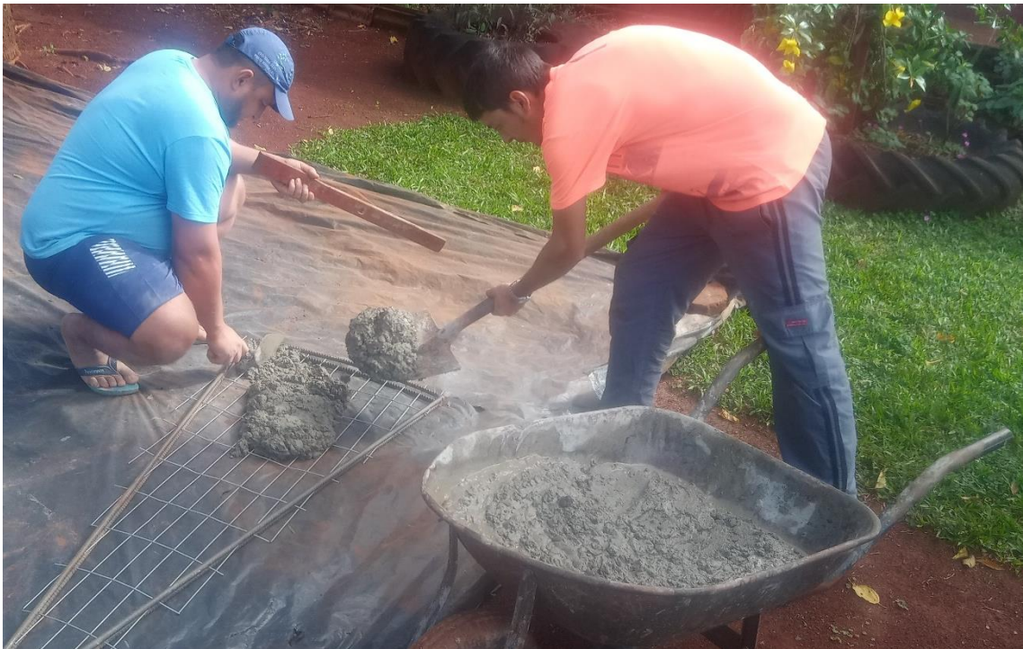
Figura 33 - Fabricação das placas
