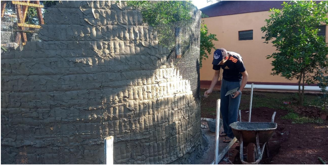
Figura 43 - Construção da primeira camada externa da cisterna
