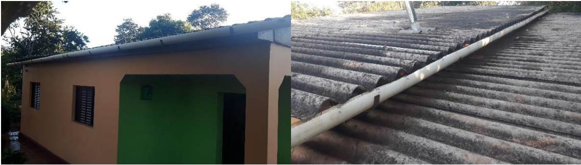
Figura 24 - Calhas instaladas na residência
