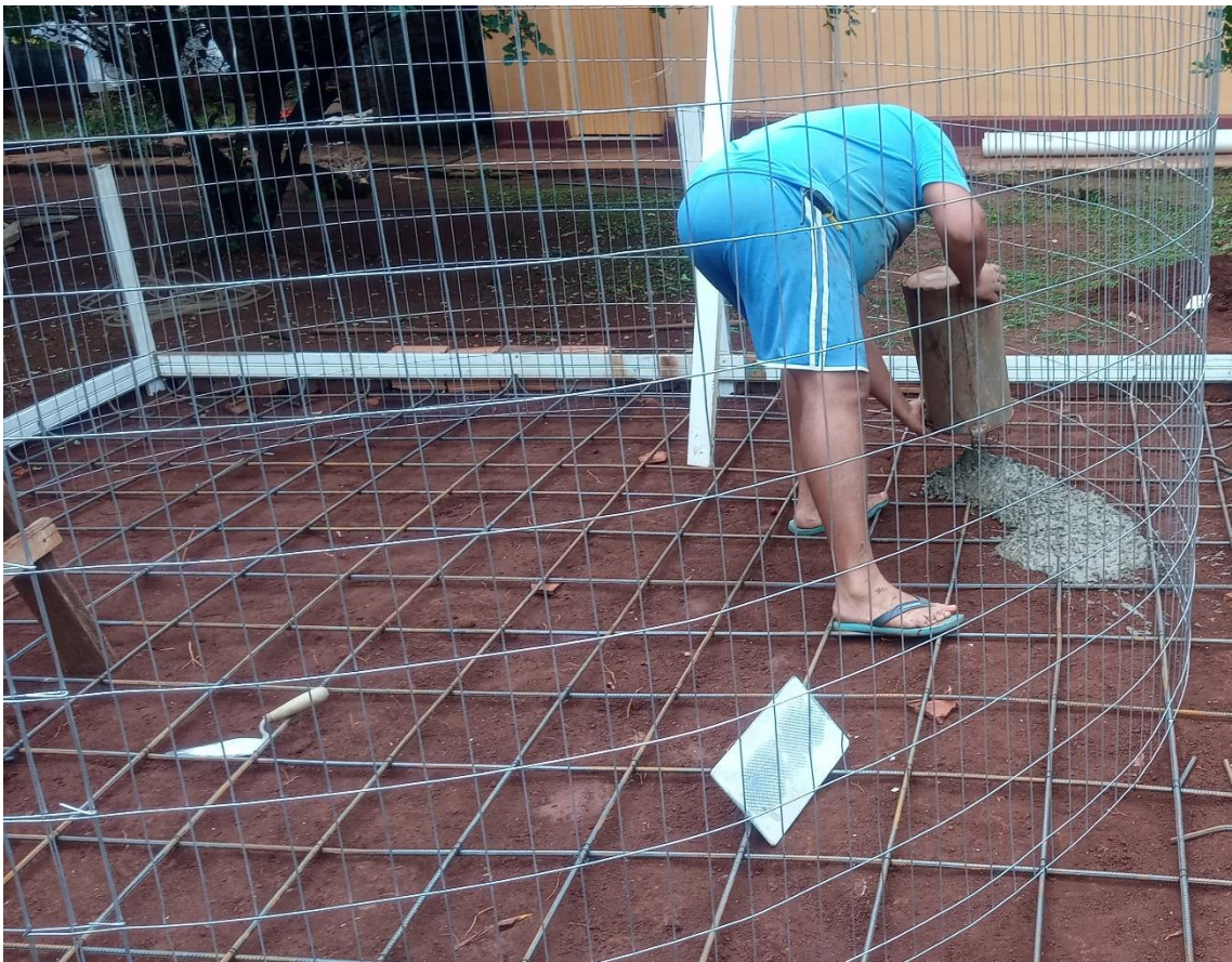
Figura 40 - Início da construção da base da cisterna
