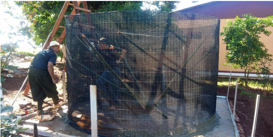
Figura 42 - Colocação do sombrite 50% ao redor da tela de alambrado
