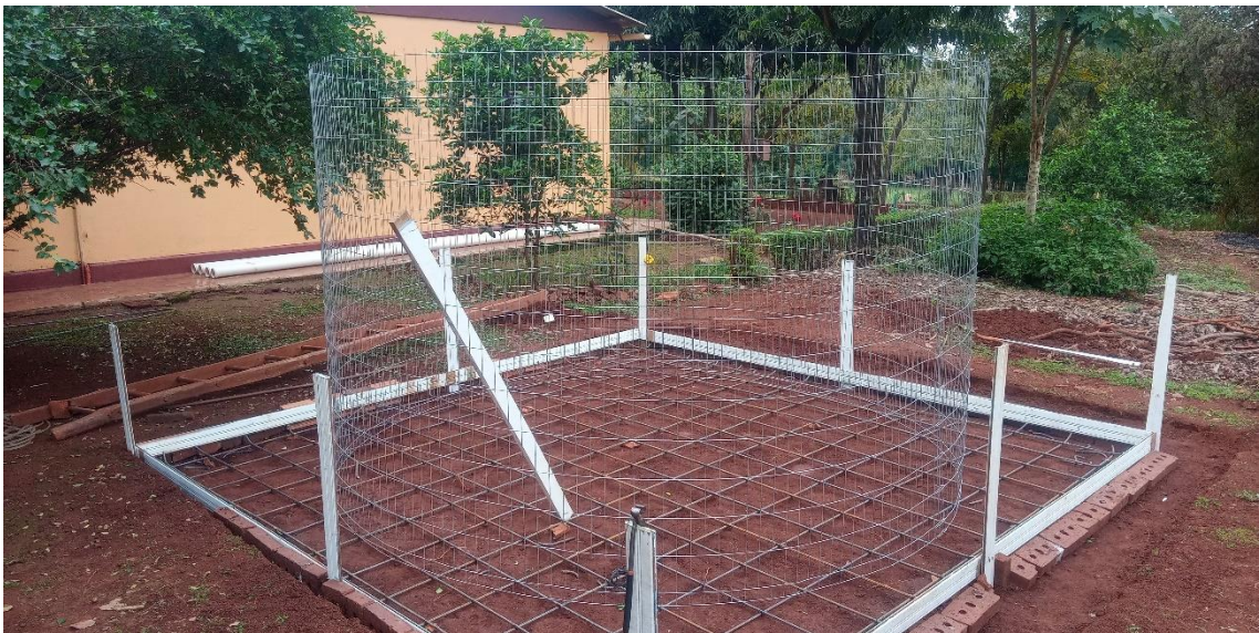
Figura 39 - Tela posicionada e devidamente fixada sobre a estrutura de ferro
