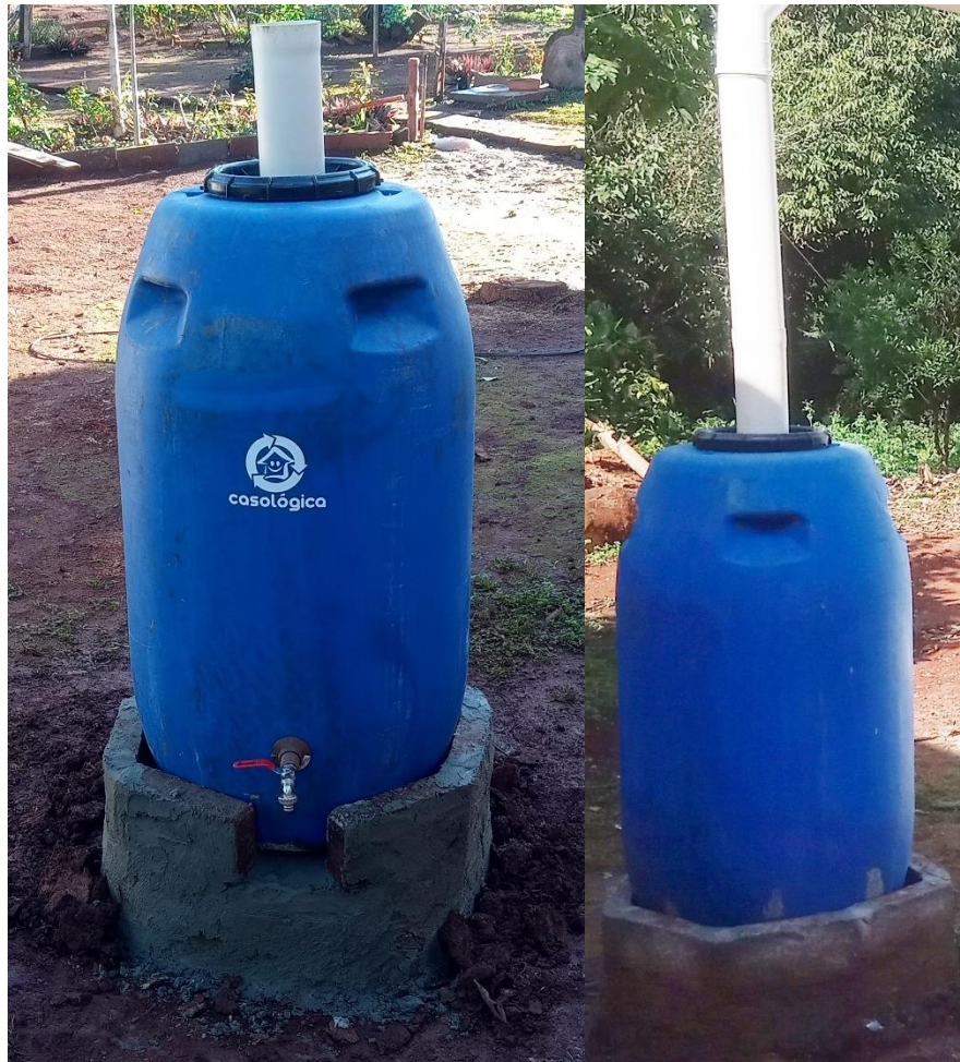
Figura 28 - Separador de águas
