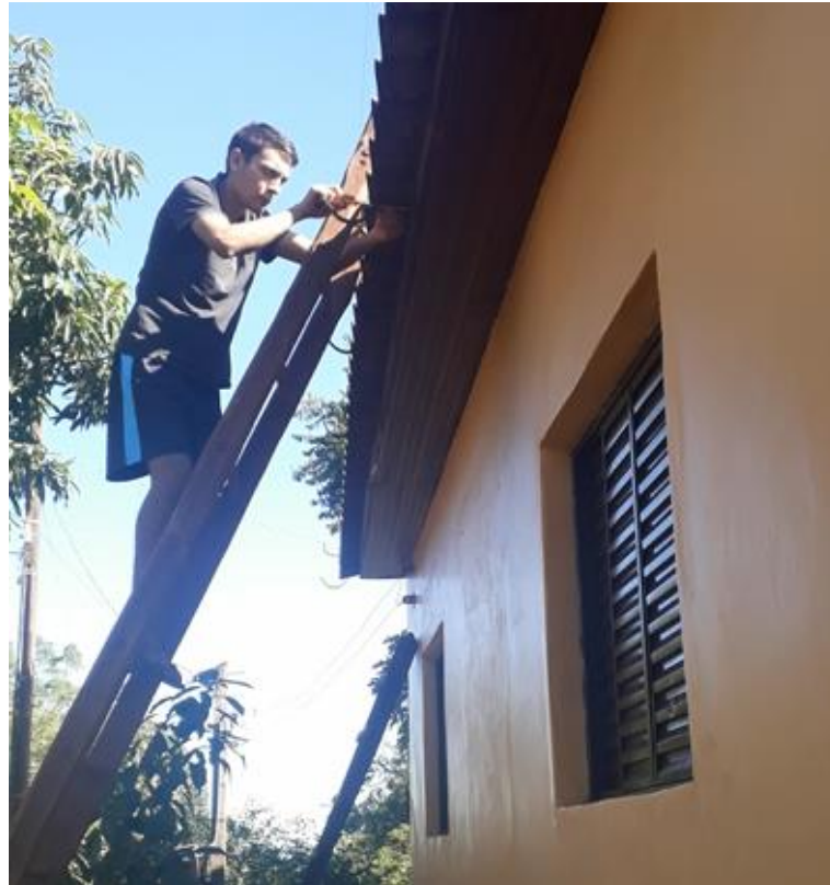
Figura 23 - Colocação dos suportes
