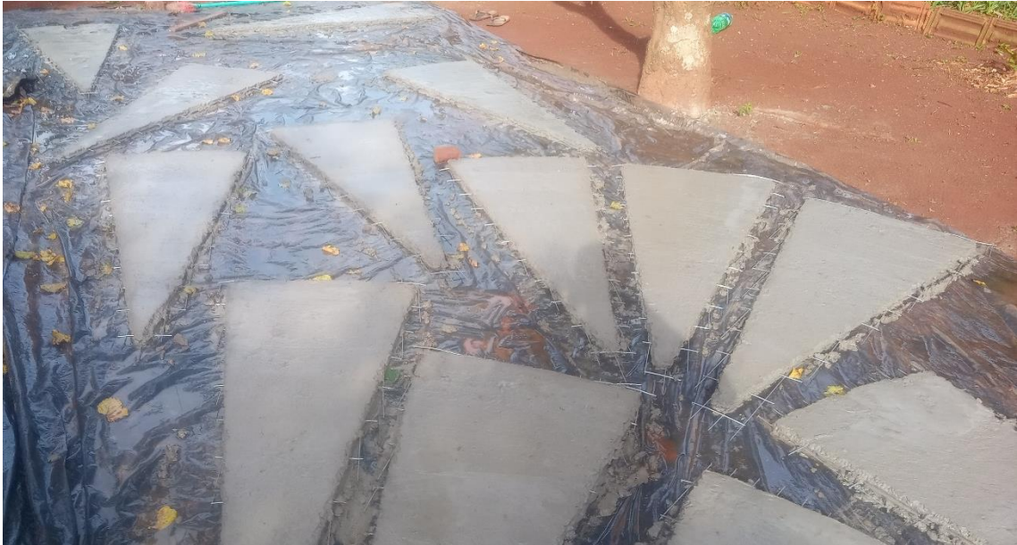
Figura 34 - Placas recém-fabricadas
