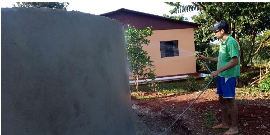
Figura 48 - Molhando a parede da cisterna
