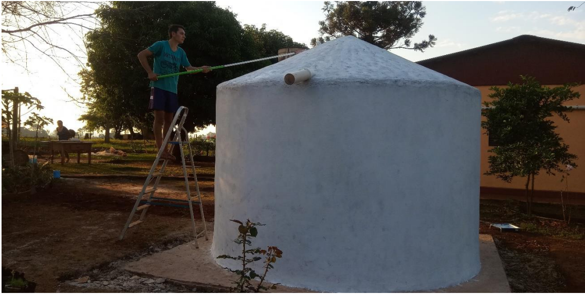
Figura 64 - Aplicação da tinta na cisterna
