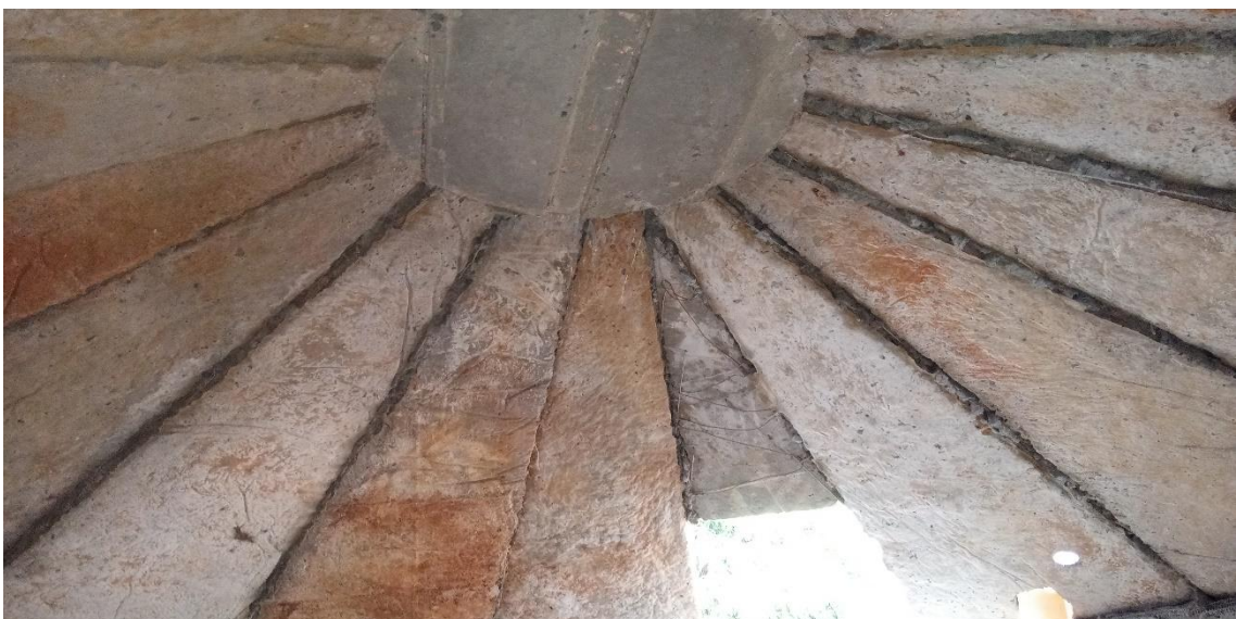
Figura 57 - Remoção da escora após alguns dias da finalização do teto
