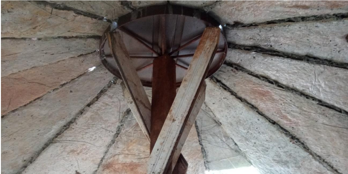
Figura 54 - Escora apoiando as placas
