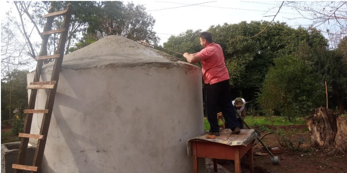
Figura 56 - Finalização do emparelhamento do teto da cisterna
