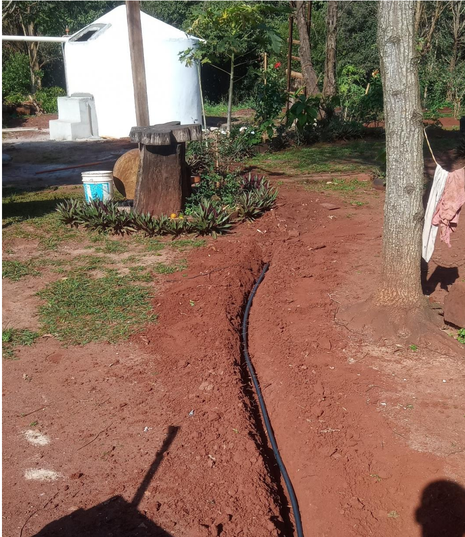
Figura 69 - Mangueira colocada a partir da bomba até a horta a ser irrigada
