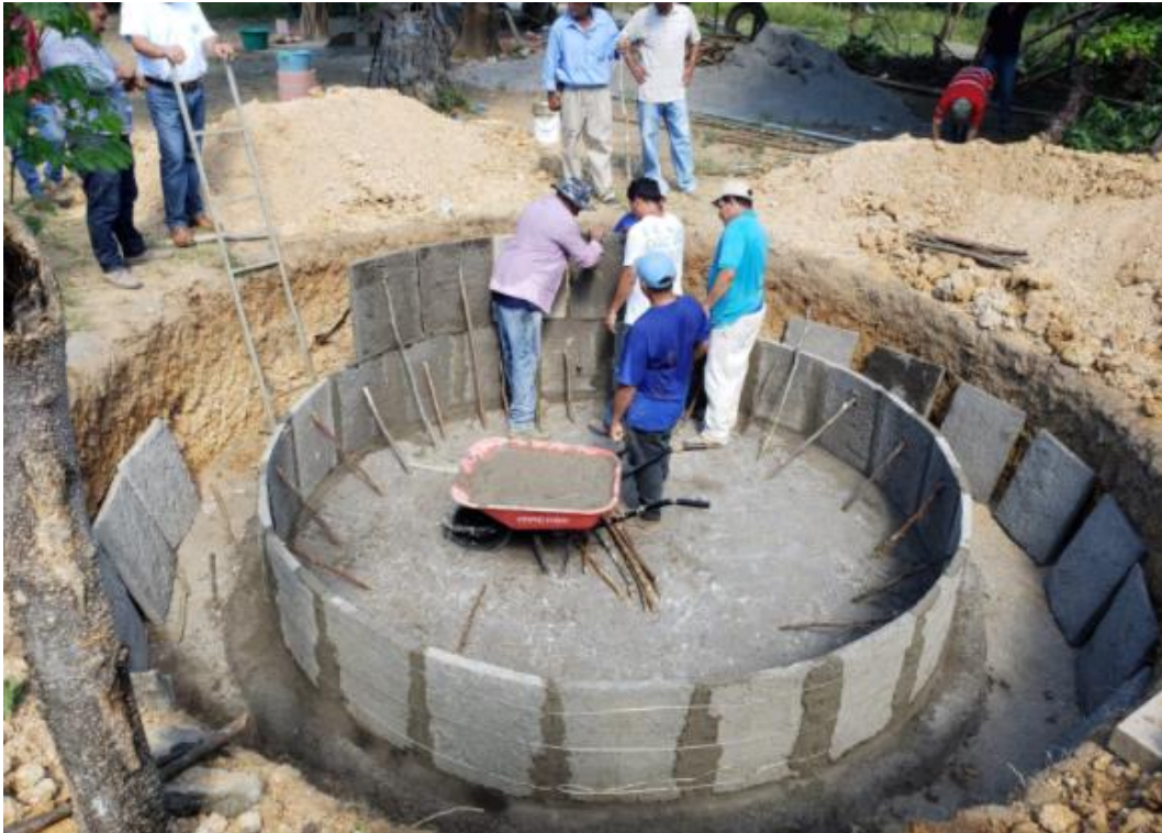
Figura 6 - Construção de uma cisterna de placas
