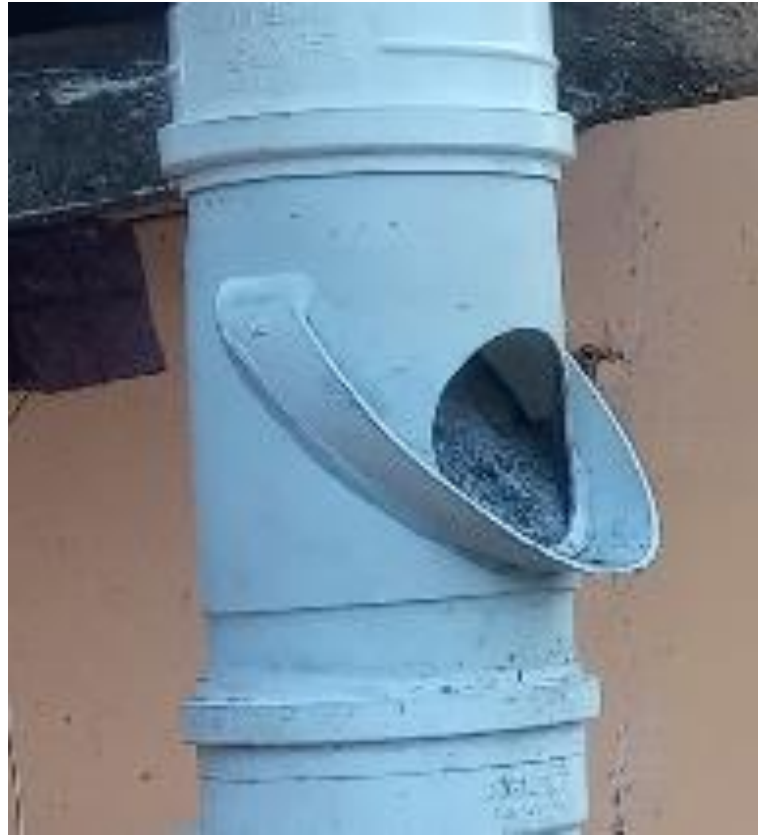
Figura 27 - Filtro autolimpante.
