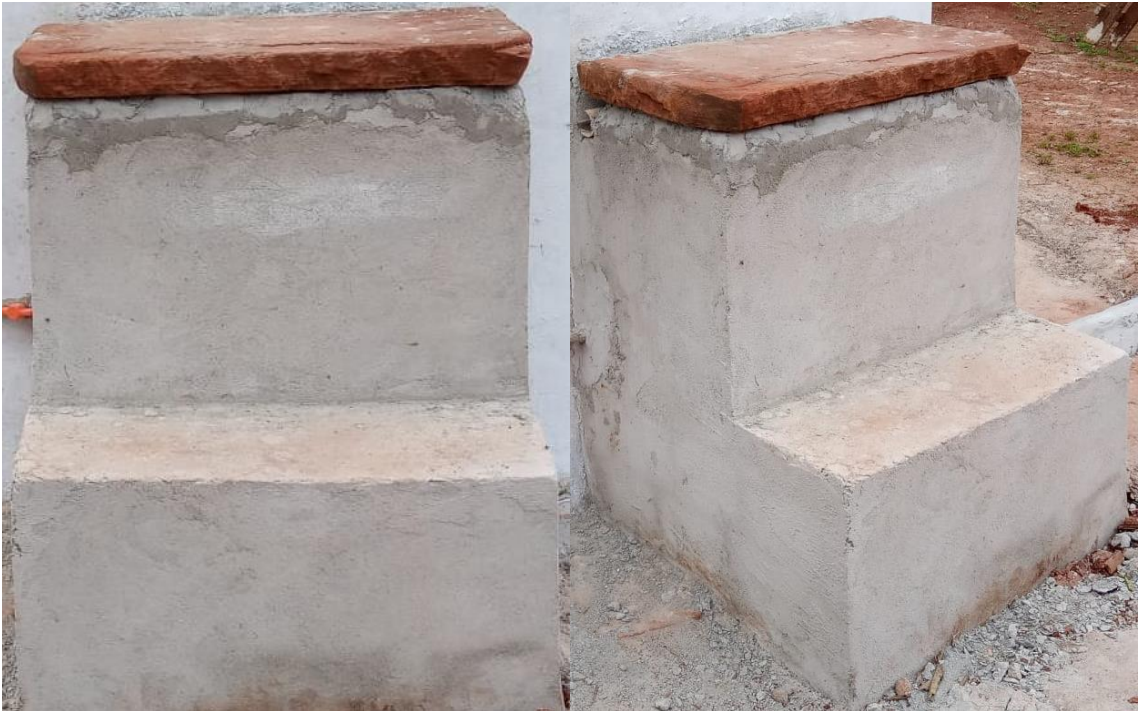
Figura 62 - Escada da cisterna
