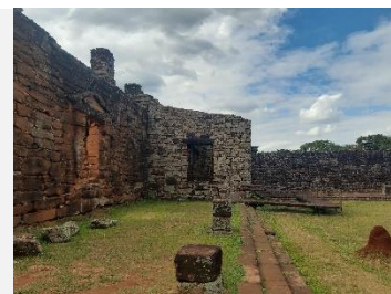
Estreitamento Parc. Enclausuramento M
