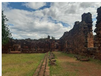
Estreitamento Parc. Enclausuramento M
