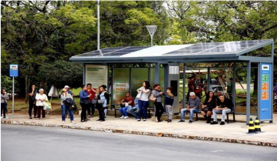
Figura 16: Porto Alegre possui ponto de ônibus tecnológico com energia solar (Adaptado de Gaúcha Zero Hora, Porto Alegre, 2018)
