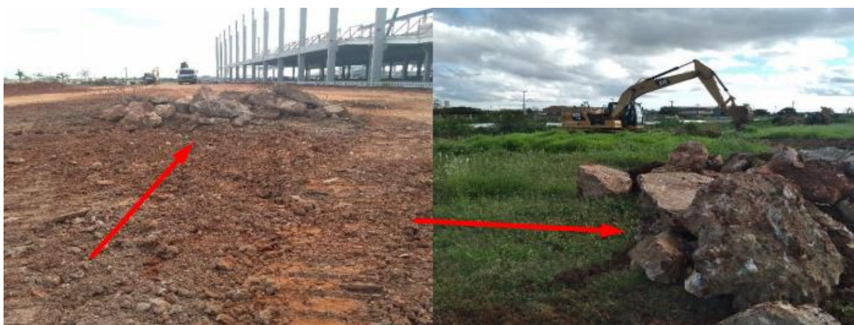
Imagem 08: Compilado de fotografias da obra com destaques nos entulhos que estavam na parte superior do solo do terreno.
