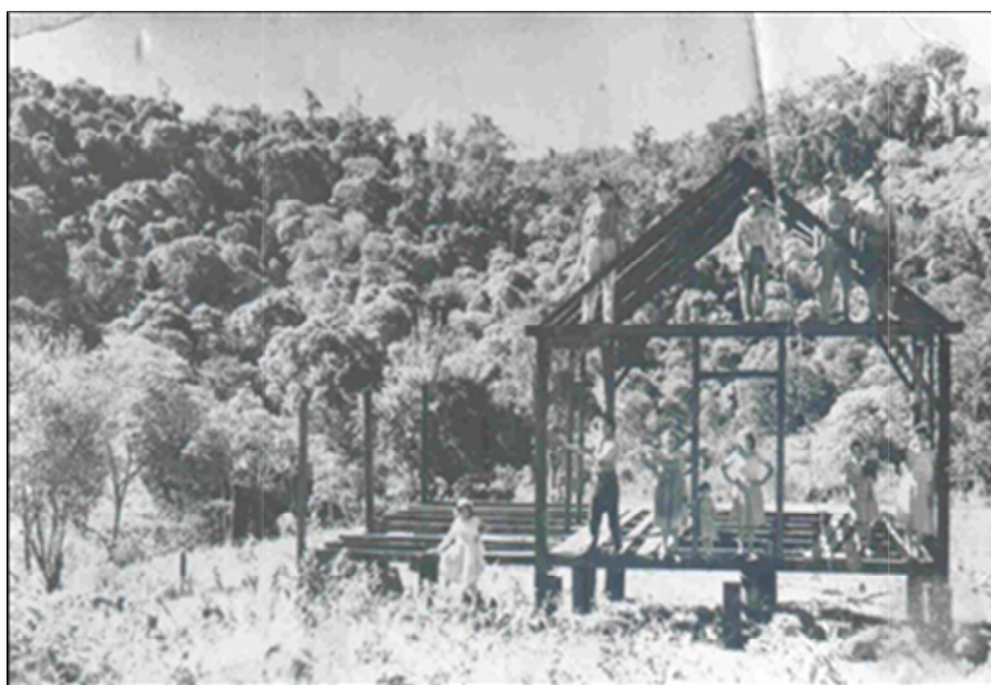
Figura 10: Aproveitamento da madeira para construção de casas dos colonos
