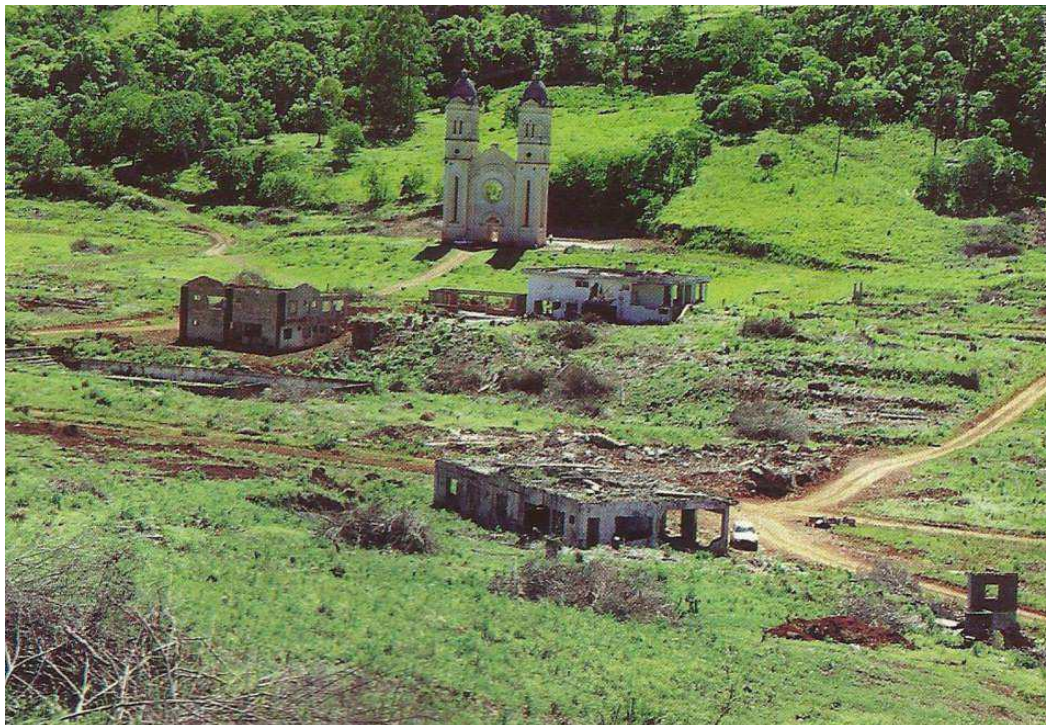
Figura 6- Antiga Itá sob processo de remoção das construções, década de 1990.
