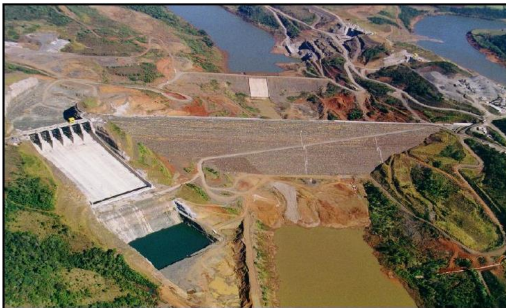
Figura 4: UHE Itá em fase de construção
