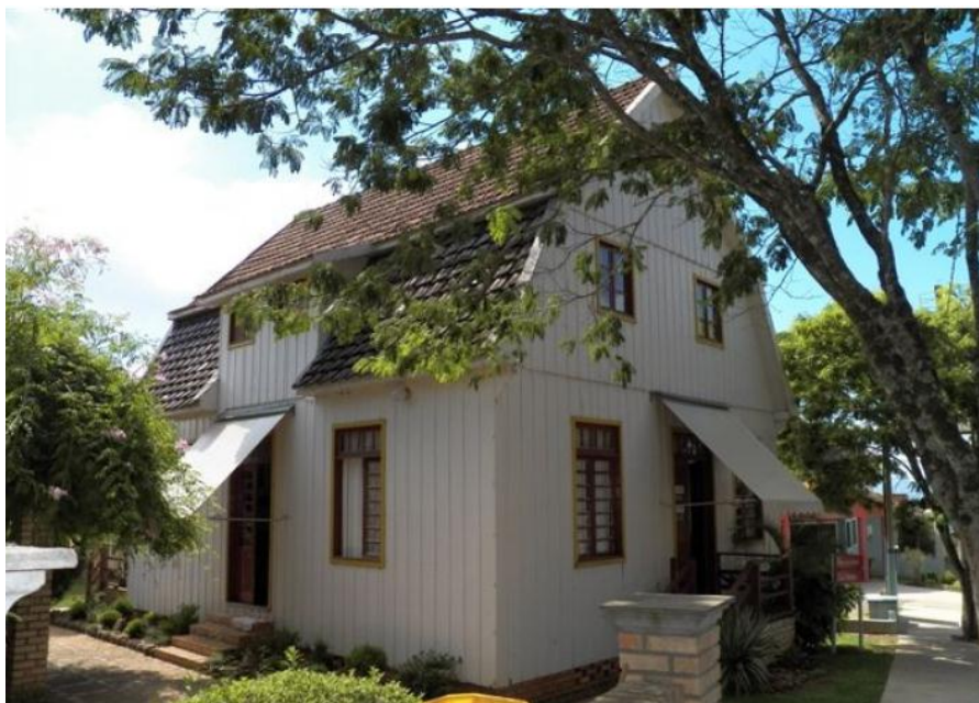
Figura 9 – Casa Alberton na cidade de Itá.
