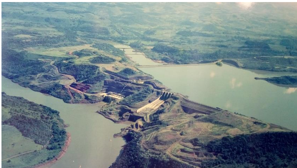
Figura 7- Usina Hidrelétrica Itá em funcionamento.
