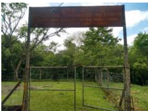
Figura 7 - Vista da entrada da ETE "G".
