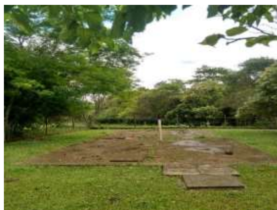
Figura 8 - Vista da ETE "G".
