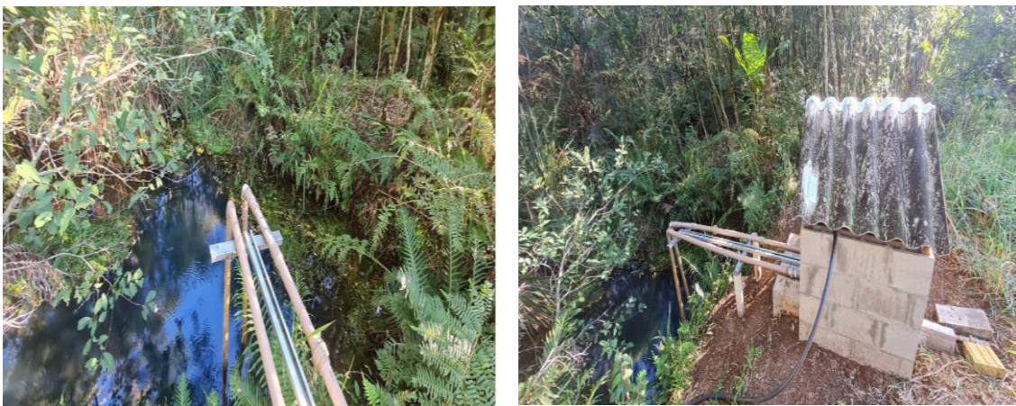
Figura 7 e 8 - Mina d'água estação experimental agronomia UFFS
