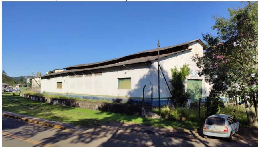
Figura 27 – Armazéns pertencentes ao silo - 2023
