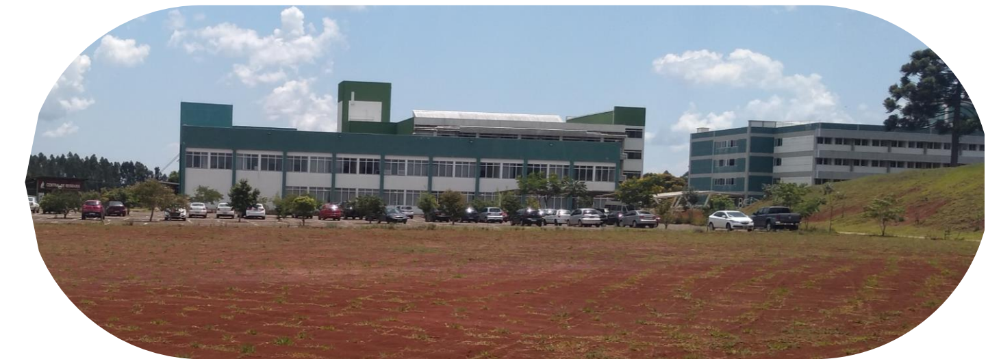
Vista do terreno para o Bloco dos professores
