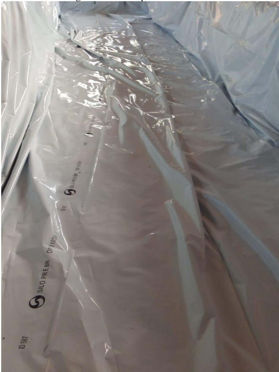
Figura 18 - Colocação das lonas na estrutura
