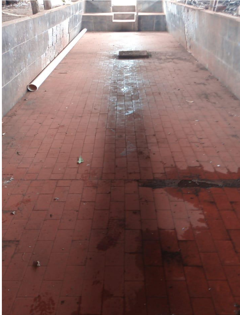
Figura 17 - Estrutura pré-existente, posteriormente utilizada para o reservatório
