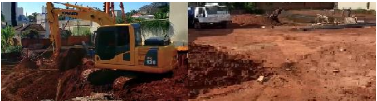
Figura 4 – Etapa Construtiva Obra 01 Fundação.
