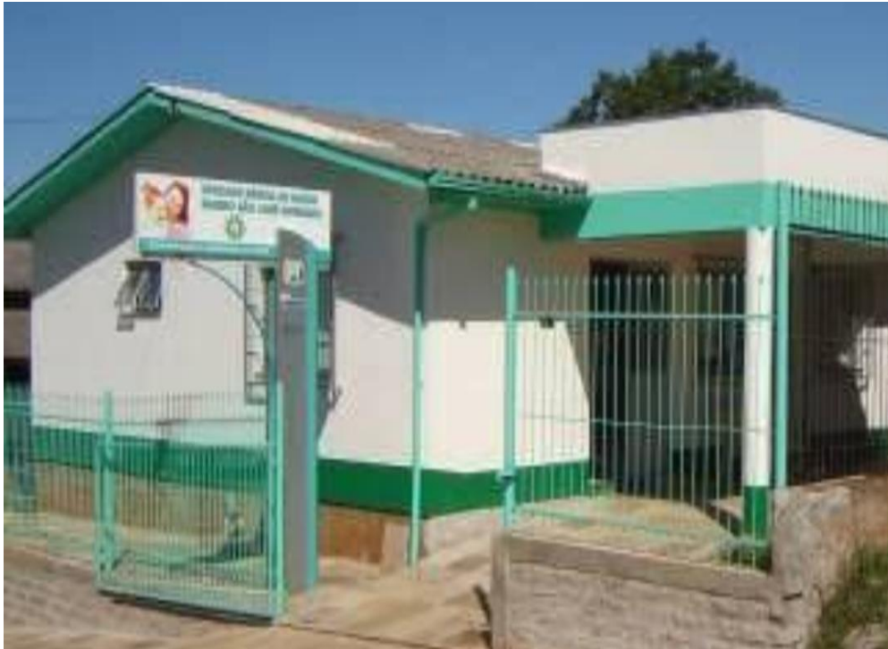
Figura 8 - Fachada ESF antes da reforma.
