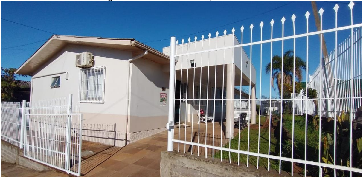
Figura 9 - Fachada ESF após reforma.
