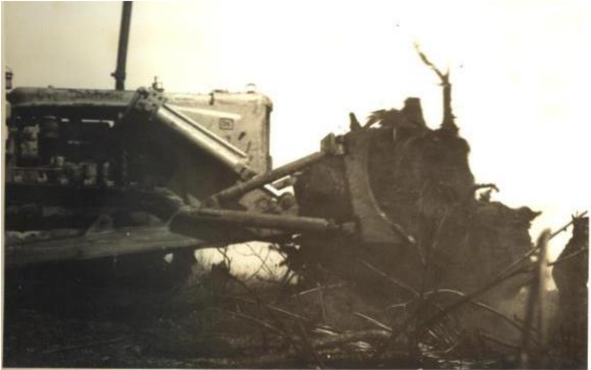
Imagem 6: Trator realizando o destocamento no talhão 16
