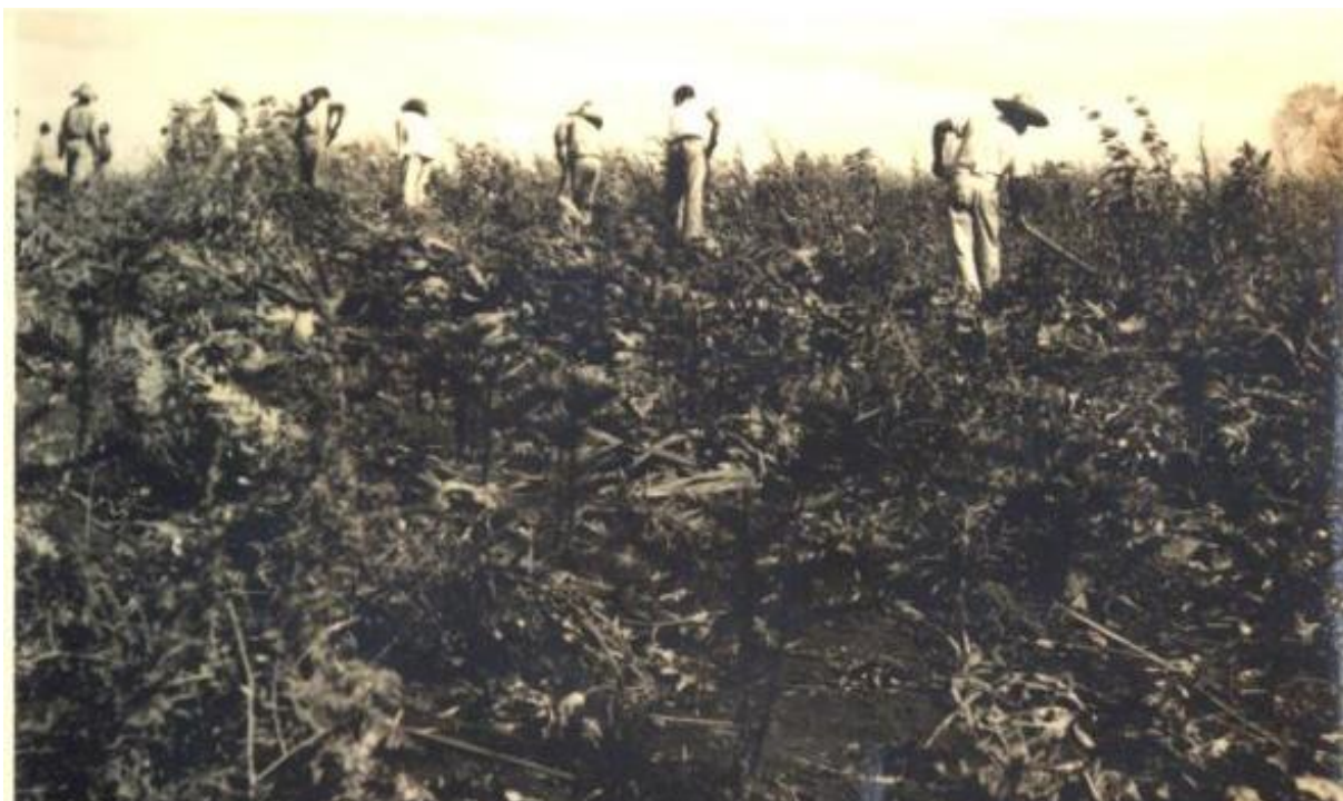
Imagem 12: Trabalhadores executando limpeza manual, em 1954, de talhão plantado em 1953
