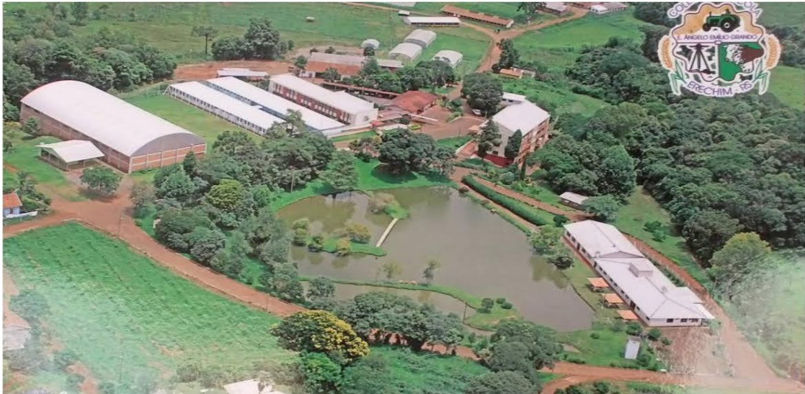
Figura 7: Estrutura do Colégio Agrícola Estadual Ângelo Emilio Grando, Erechim (RS).
