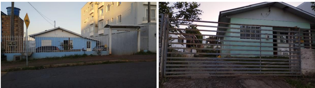
Figura 7. Casas populares, hoje já reformadas, localizadas no loteamento Colatto, bairro Efapi
