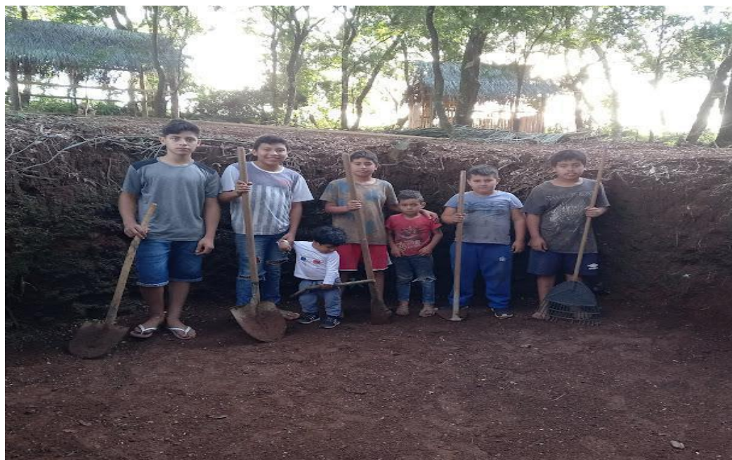
Figura 21 - limpeza do espaço para construção da casa subterrânea
