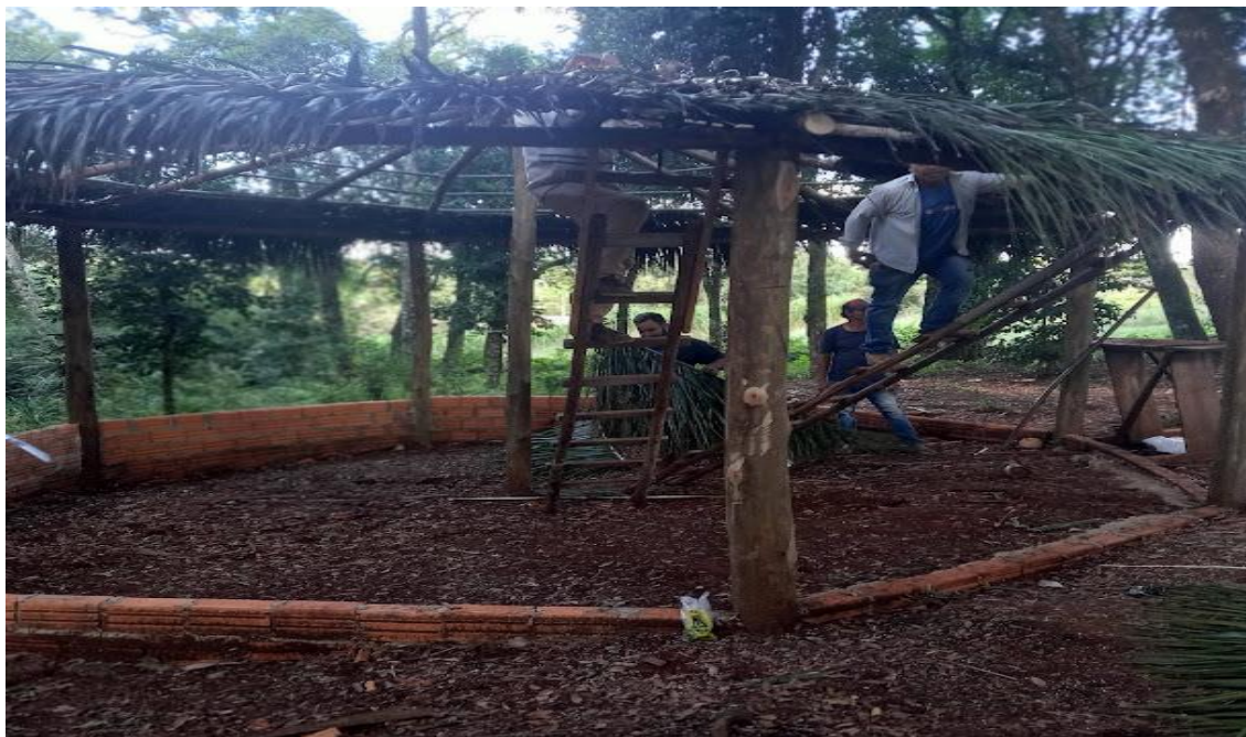
Figura 23 - Construção da casa cultural 2022
