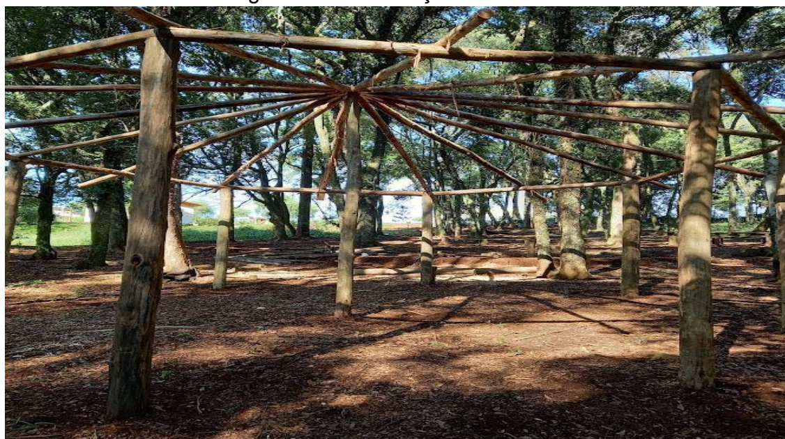
Figura 22 - Construção da casa cultural
