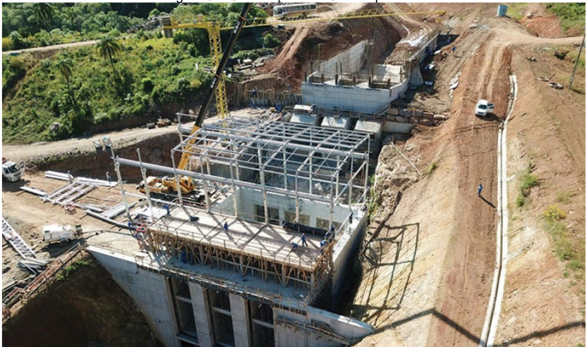
Figura 3 - Construção da PCH Forquilha IV
