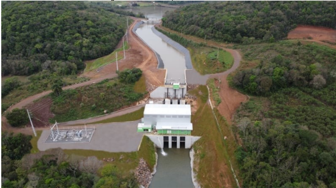
Figura 4 - PCH Forquilha IV finalizada
