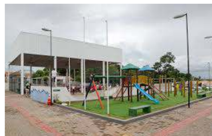
Imagem 14. CEU Erechim - equipamentos públicos.
