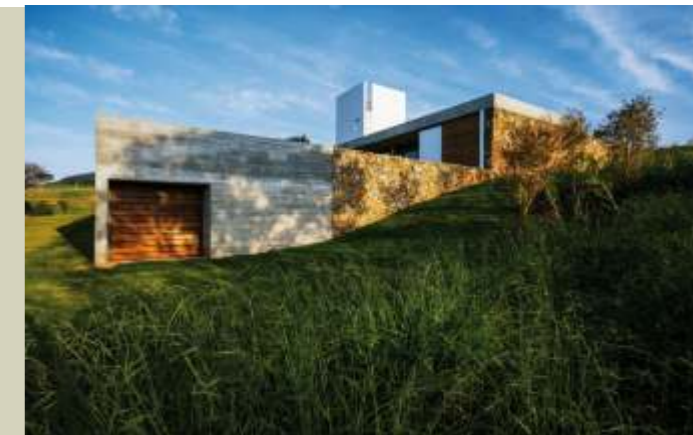
Imagem 35. Vista do desnível
