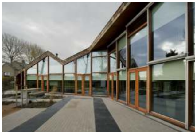
Imagem 37. Desconstrução da volumetria e coberturas
