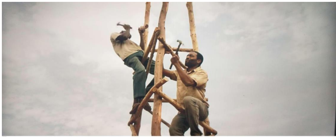
Figura 2: Dois homens martelando na construção do moinho de vento
