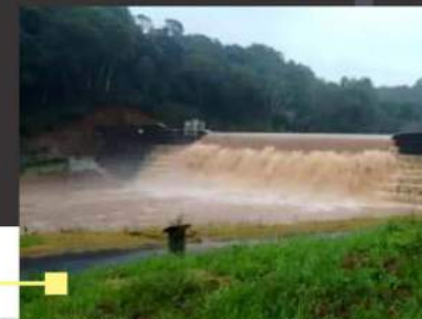
Figura: Barragem de Contenção do Rio Queimados | Concórdia-SC. Fonte: http://s2.glbimg.com/piFoE7lrN19nSwCBTLnq3nmNoYc=-/620x465/s.glbimg.com/jo/g1/f/original/2015/07/14/atual_barragem_de_contencao_no_rio_dos_queimados.jpg
