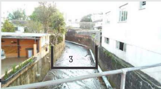
Figuras 01-02-03: Canalização Rios dos Queimados. Fonte: acervo autor
