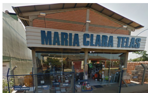
Imagem: Edificação de uso comercial Fonte: Google Street View
